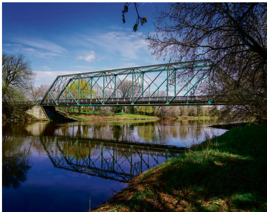
Le pont Paré. Photo François Larivière | La Pensée ©
