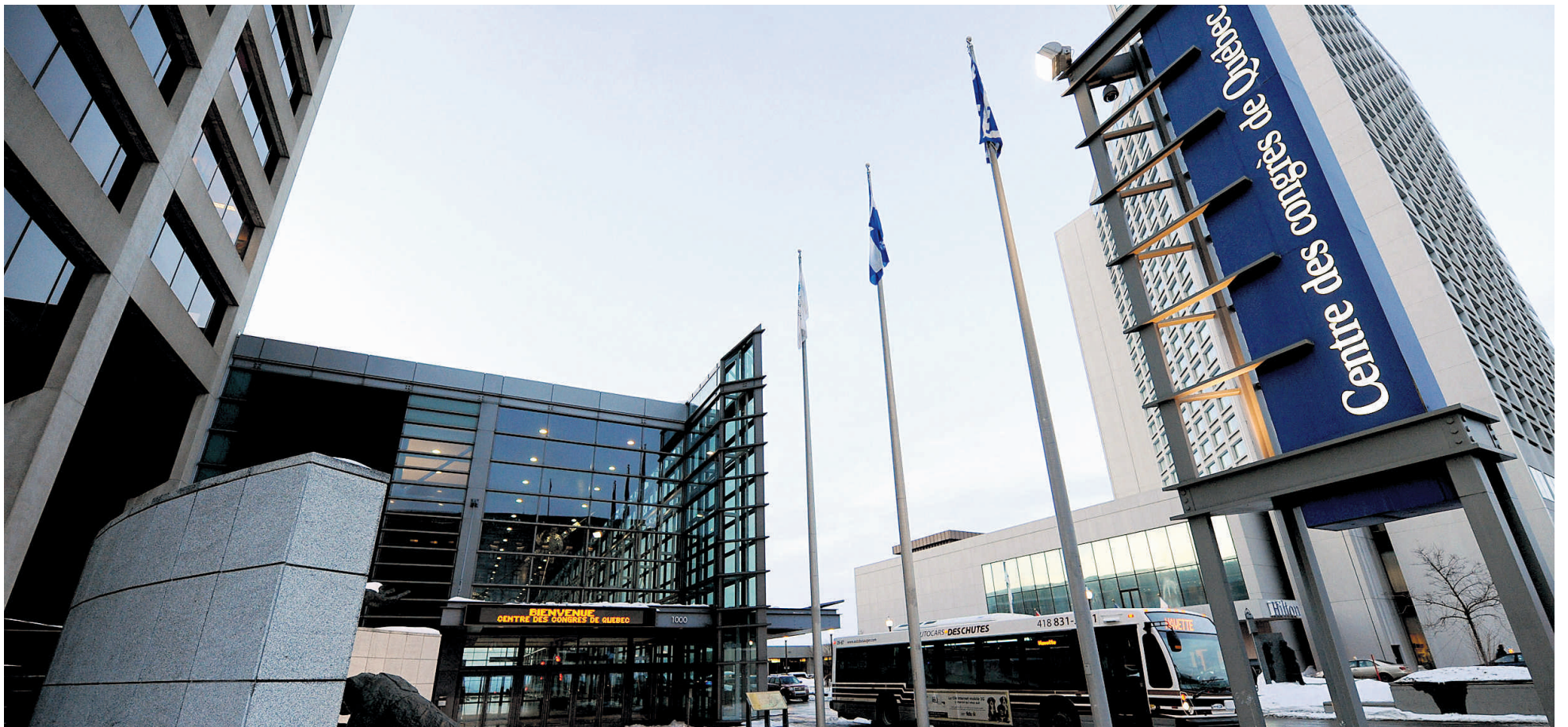
L'acquisition par le Centre des congrès de quelque 65 000 pieds carrés de Place Québec, servirait à l'aménagement de différentes salles de rencontre, d'espaces de rangement et d'une cuisine. — PHOTO LE SOLEIL, ERICK LABBÉ
