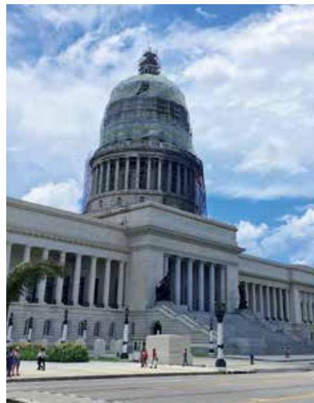
Capitole de La Havane durant sa restauration
