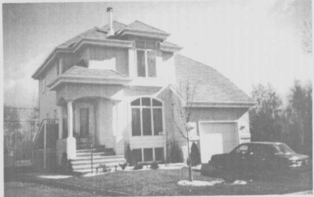
En 1994, dans la MRC des Moulins, il s'est construit 996 logements, ce qui représente une hausse de 29,5% par rapport à 1993. Le secteur de la maison détachée a connu une hausse de 22%. On peut voir sur cette photo, l'un des modèles de Construction Nord-Est.
