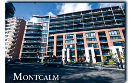
MONTCALM LE 650 AV WILFRID-LAURIER 559 500 $ Condominium à l'esprit jeune et contemporain, proportions équilibrées, lignes épurées, vue dégagée.
