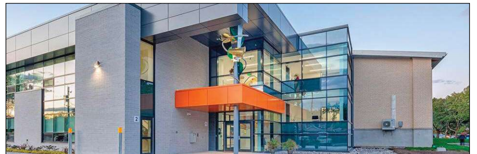
L'agrandissement de l'école des Écrivains qui comporte huit nouvelles classes et un gymnase double a nécessité un investissement de 4 M$.
