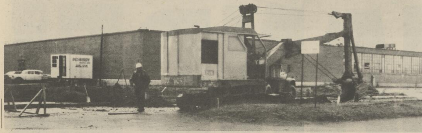
LES TRAVAUX PRELIMINAIRES à la construction des piliers du futur agrandissement de l'usine de la Cyanamid de St-Jean ont débuté depuis quelque temps. Cette usine, afin de faire face aux nombreuses demandes du marché, a dû procéder à l'agrandissement de son plan à St-Jean. La
