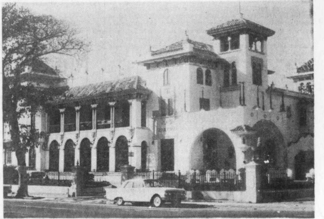
Casa di Espana, luxueux club privé et casino, à San Juan, Porto Rico. Construit en bordure de l'eau, c'est le premier immeuble qu'aperçoivent les passagers de l'"Empress of Canada" quand le paquebot de croisière approche ce port.
