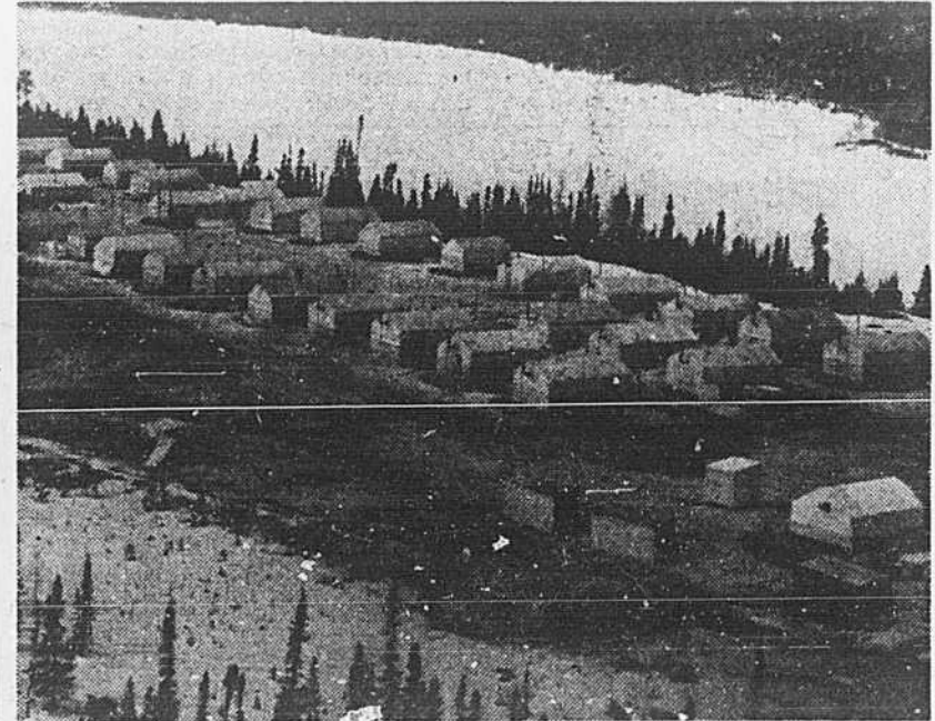
Quand toutes les roulottes enreposées en bordure de la route, à Matagami, seront montées dans les chantiers, on ne verra plus de tentes sur les bords de la rivière La Grande comme ci-haut.
