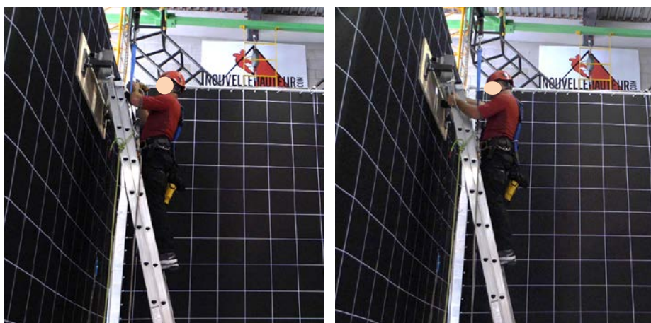
Figure 45. Vissage entre les montants de l'échelle.
