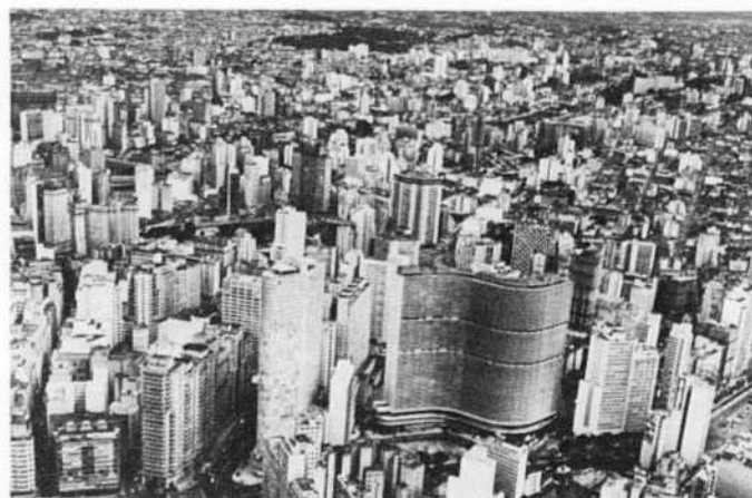
UNE VUE AERIENNE de Sao Paulo, montrant la construction incurvée de l'Edificio Copan, la plus grande structure en béton au monde.
