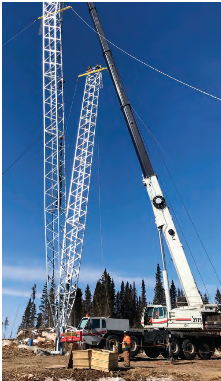
Les travaux de la ligne Micoua-Saguenay avancent bien malgré les défis amenés par la pandémie. Dans certaines sections, des pylônes sont déjà érigés. Photo Hydro-Québec
