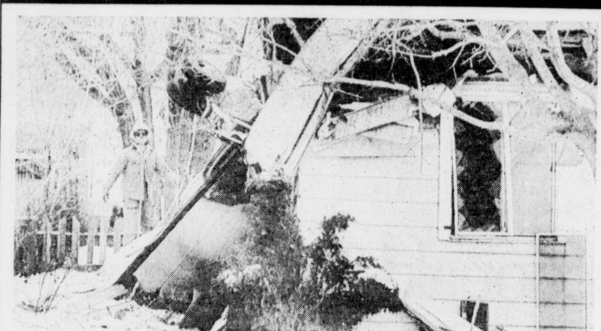
Des débris du bimoteur sont tombés sur cette maison. En haut, au centre gauche de la photo, on remarque notamment une partie du train d'atterrissage de l'appareil.
