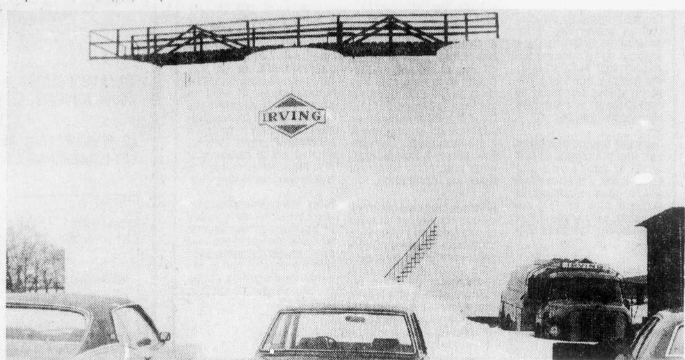
Bientôt le prolongement... Il ne reste plus qu'à déménager ces réservoirs pour que les travaux de prolongement de la rue St-Paul puissent être entrepris. (Photo La Tribune, Victoriaville, Serge Beucher)
