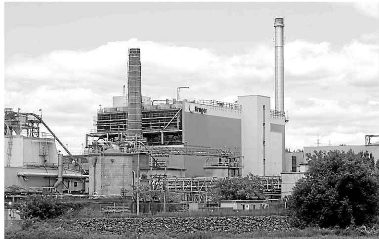
Le site de l'entreprise à Brompton accueillera une nouvelle usine destinée à produire chaque année 70 000 tonnes métriques de papier hygiénique et d'essuie-tout. — PHOTO LA TRIBUNE
