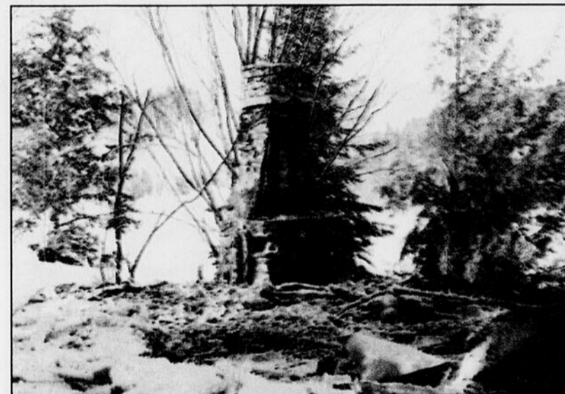
Photo La Tribune, par Pierre Saint-Jacques. Les flammes ont rasé un chalet sur les rives du lac Au bran de scie, Canton Orford, dans la nuit de lundi à hier. Du rez-de-chaussée, il ne reste que la cheminée.
