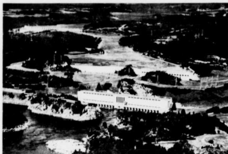
La centrale de Shipshaw
