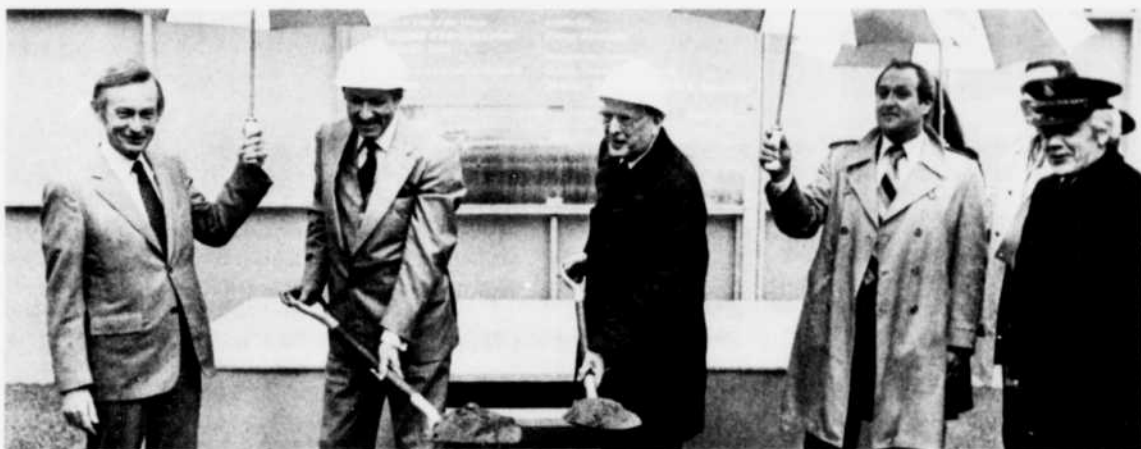
Assisté du Commissaire John Waldron, de l'Armée du Salut, le président d'Alcan, David Culver, procède à la première pelletée de terre sur le site du futur siège social international de notre entreprise. (Photo Barry McGee)
