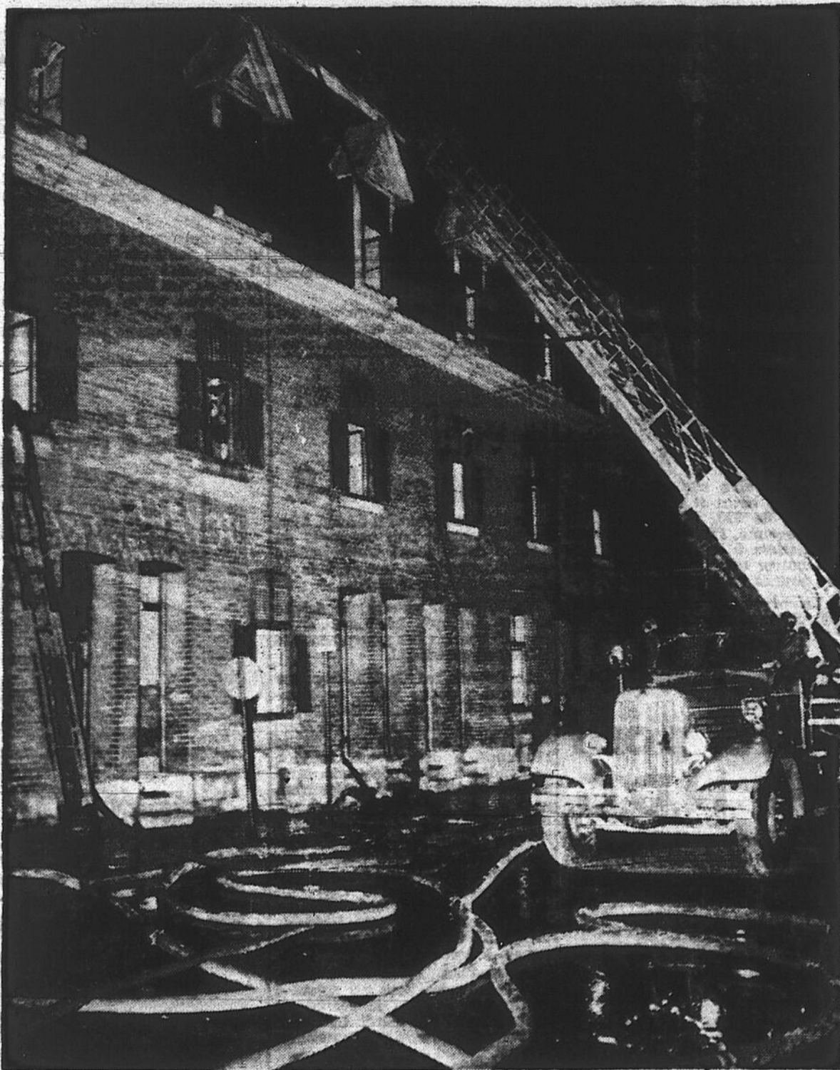
LES POMPIERS SONT SUR LE TOIT — L'incendie est presque terminé, mais des pompiers sont encore sur le toit. (Photo "Montréal-Matin", par David Bier)
