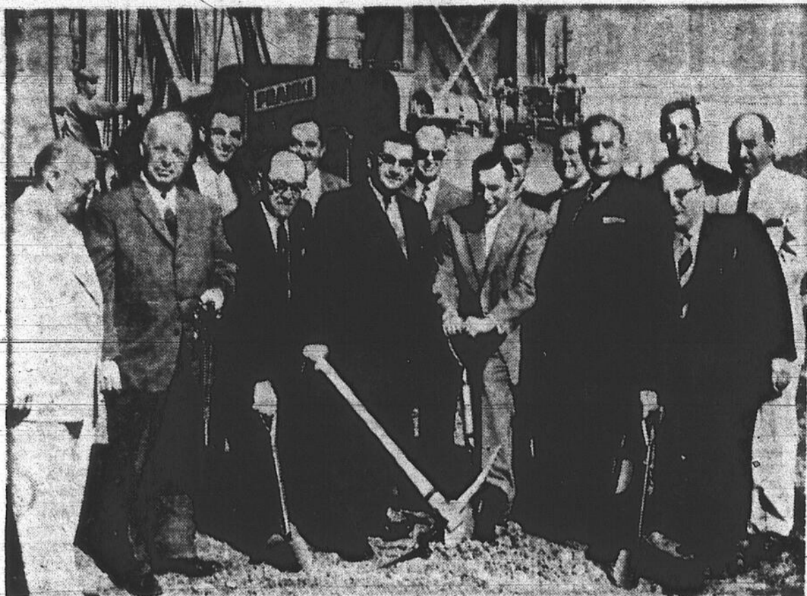
CENTRE RECREATIF A COTE-ST-PAUL — La construction du Centre récréatif du parc des Conseillers, à Côte-St-Paul, a débuté hier. Ce centre comportera une piscine, une magnifique gymnase, des salles de jeux et des pièces pour les adeptes de l'artisanat. Les conseillers du district ont tenu à lever la première pelletée de terre de ce projet. On les voit, ici, de gauche à droite: MM. W.-E. Lauriault, Bruno Lépine, H. "Pit" Lessard, Marcel Lafaille, leader du Conseil municipal, Germain Angrignon et Raymond Mondor. On reconnaît également MM. Gaston et Bernard Dupuis, A. Morrissette, du service des travaux publics, et quelques autres invités.
