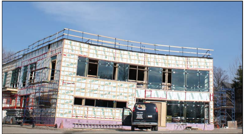
Chantier du futur Centre de santé Marie-Paule Sioui-Vincent Photo: Mélanie Vincent
