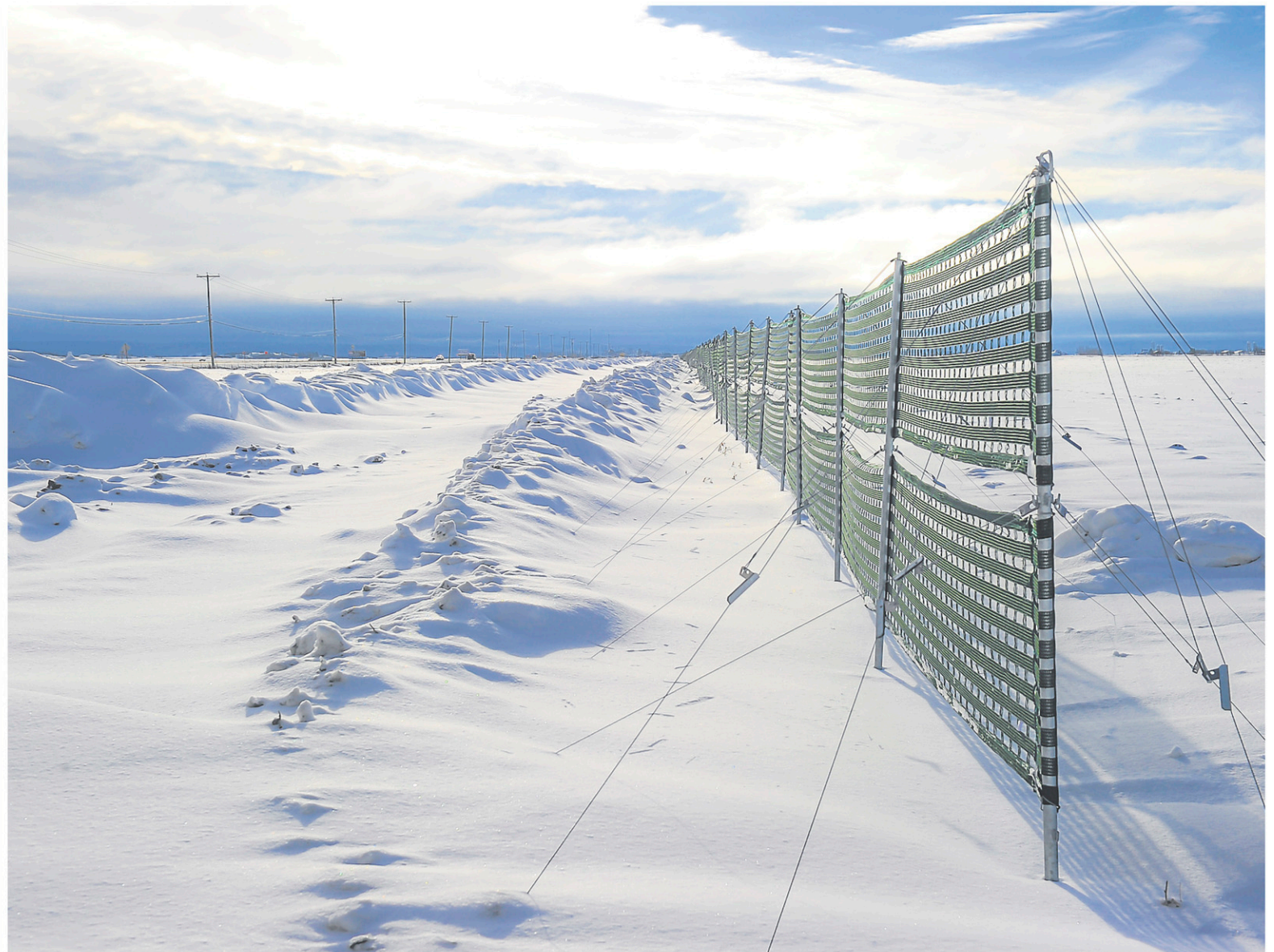
Le MTQ a procédé à l'installation de plusieurs kilomètres de clôture en vue de la saison hivernale. Une bande de plus de trois kilomètres se trouve en marge de la route 169. — PHOTO LE QUOTIDIEN, GIMMY DESBIENS
