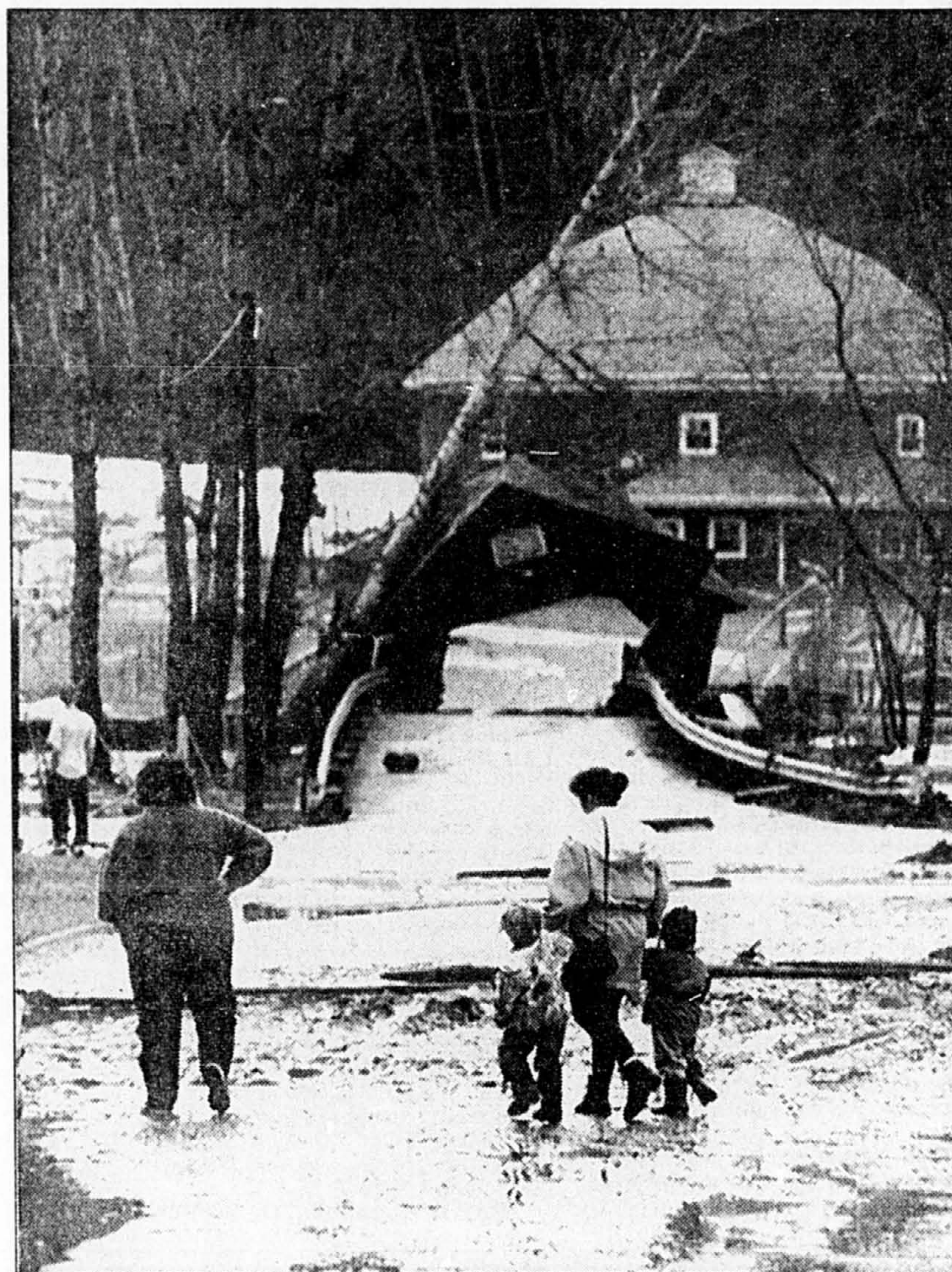
La rivière Coaticook est devenue torrent, hier. Les dommages sont particulièrement importants dans le parc de la gorge de Coaticook, où le pont couvert érigé à l'entrée tenait de peine et de misère en après-midi.
