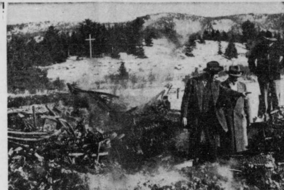
SUR LA SCENE D'UNE TRAGEDIE — Voici quelques voisins de la famille Lachapelle examinant les ruines de la maison de cette dernière, détruite par un incendie, à Lac Ste-Marie, Québec, à 54 milles au nord-est de Hull. Cette tragédie a fait quatre victimes: la mère et trois fillettes. L'époux M. Lachapelle, et sa fille Monique de même qu'un neveu ont réussi à s'échapper des flammes, mais tenèrent vainement de sauver Mme Lachapelle et ses autres fillettes.
