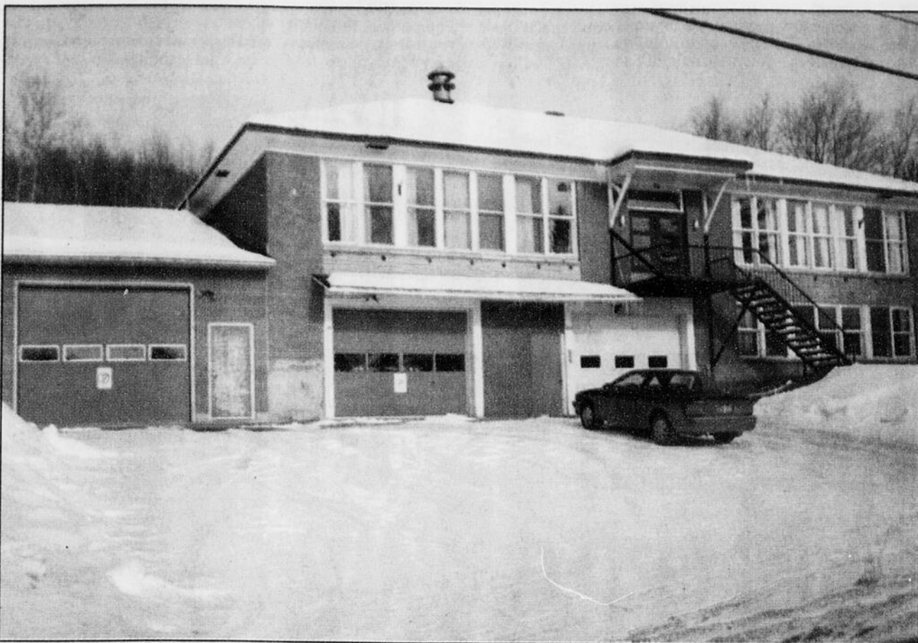
Le référendum a abouti à l'approbation d'un emprunt de 175 000 $ pour l'agrandissement de la caserne du service de protection contre les incendies et la relocalisation de l'hôtel de ville à l'intérieur de l'immeuble qui abrite le Centre communautaire.
