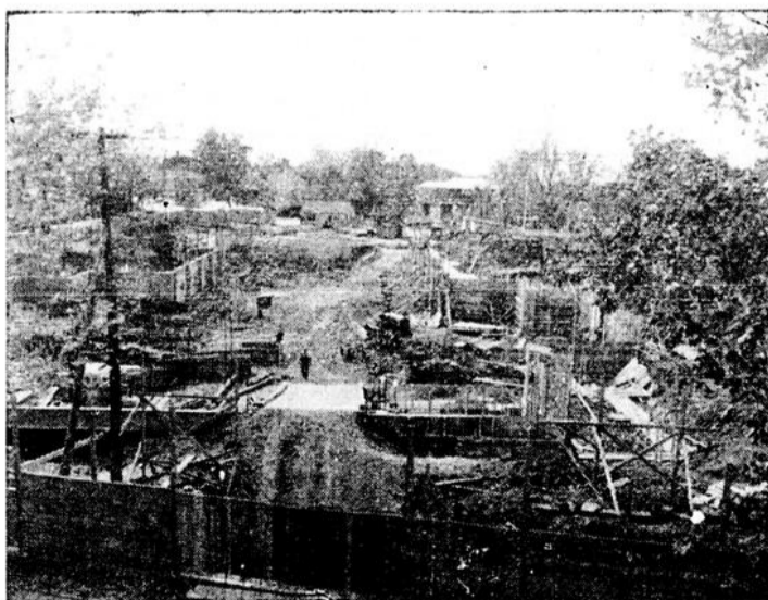
Ci-dessus l'état d'avancement des travaux sur le chantier de l'église St-Thomas de Montmagny.
