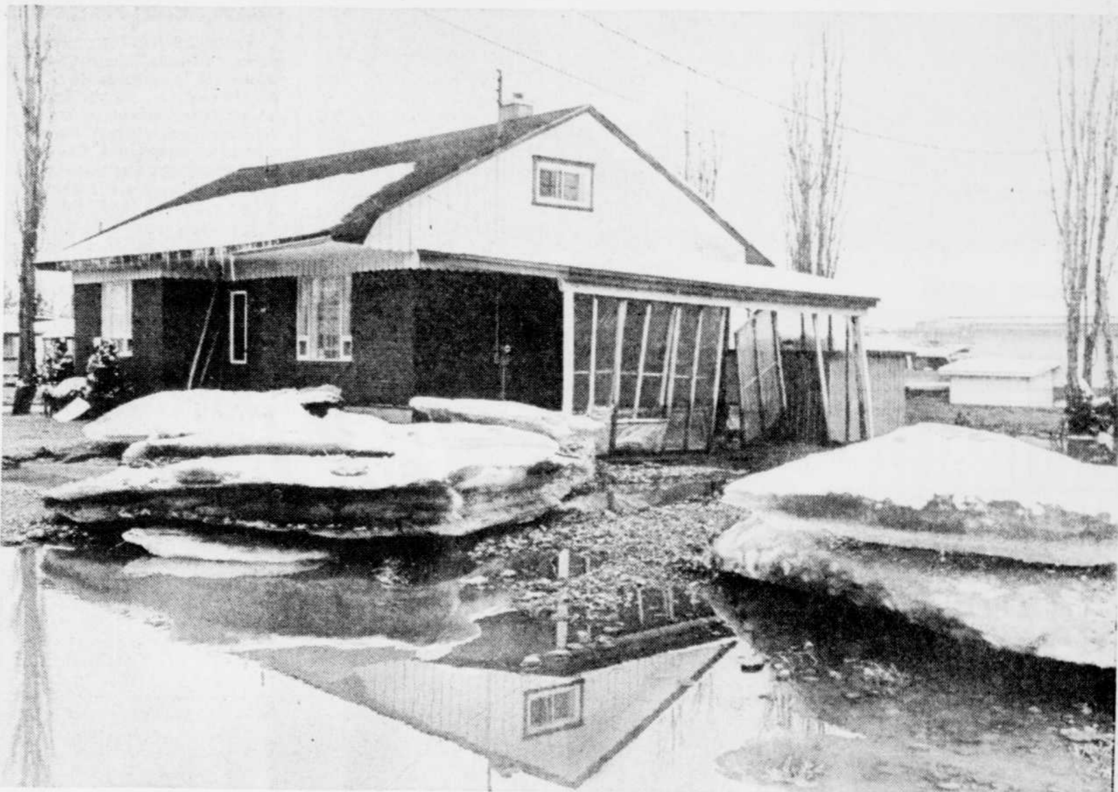
Une maison qui l'a échappé belle.
