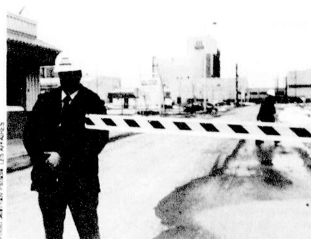
L'usine de Norsk Hydro, érigée au coût de 550 M$, a complété sa première année. Elle emploie 388 travailleurs.
