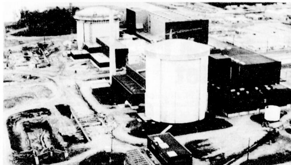
La centrale permettrait de se mettre à l'abri d'une panne de réseau qui aurait pour résultat de paralyser le fonctionnement de la centrale nucléaire de Gentilly.
