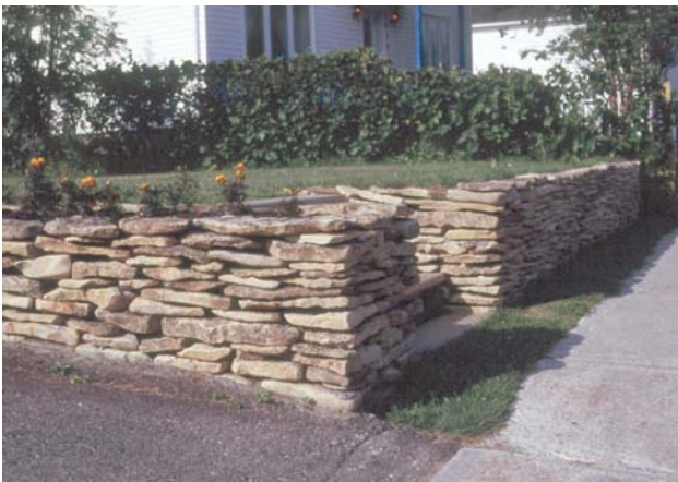
Photo 5 - Galets plats de dolomie de la Formation de Romaine utilisés pour la construction de murets de pierre.
