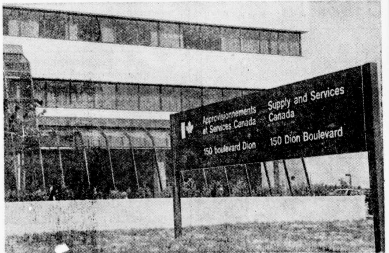
Un immeuble moderne et spacieux abrite les fonctionnaires fédéraux.
