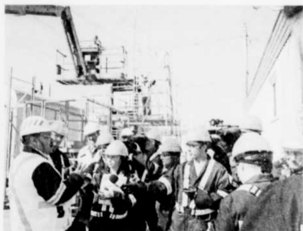
Une douzaine de représentants des médias régionaux ont fait une visite du chantier AP50 le 12 août dernier. Voici le site de formation situé à l'entrée du chantier.
