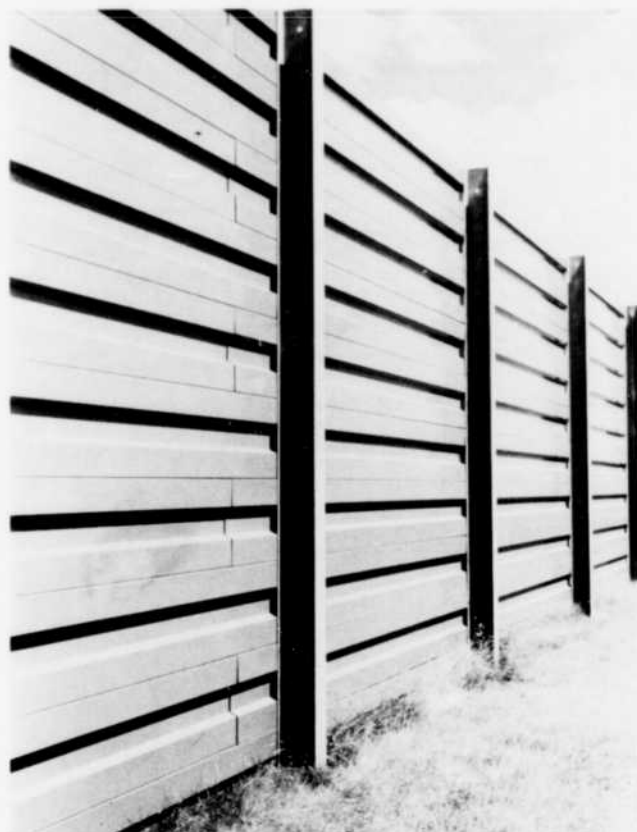
Figure 14 - Écran de protection phonique en tôle d'acier construit par le Ministère des Transports de l'Ontario, en bordure de l'Autoroute 401 (Toronto).
