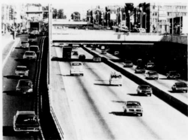
Figure 10 — Partie du boulevard Décarie située en tranchée, avec ses voies de service.
