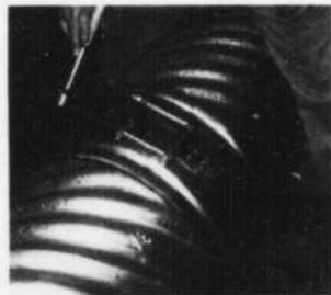
La bande d'accouplement "HUGGER", installée sur place, du tuyau "HEL-COR"
