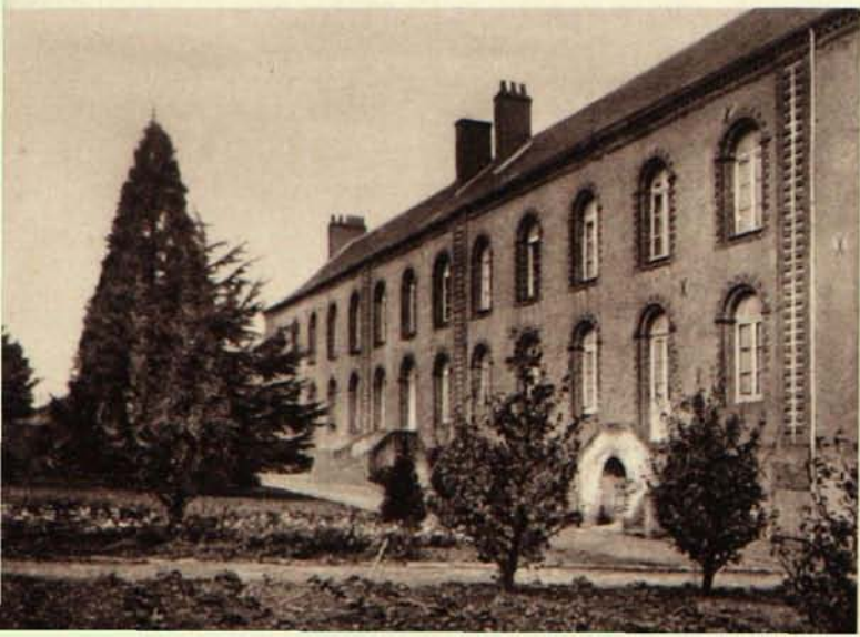
Maison-Mère, construite par le Fondateur en 1852. Aujourd'hui Centre de Formation de futures Institutrices.
