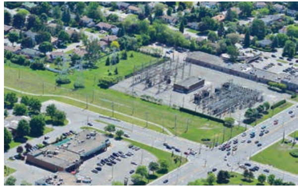
Photo 1 – Vue aérienne du poste Saint-Jean existant
