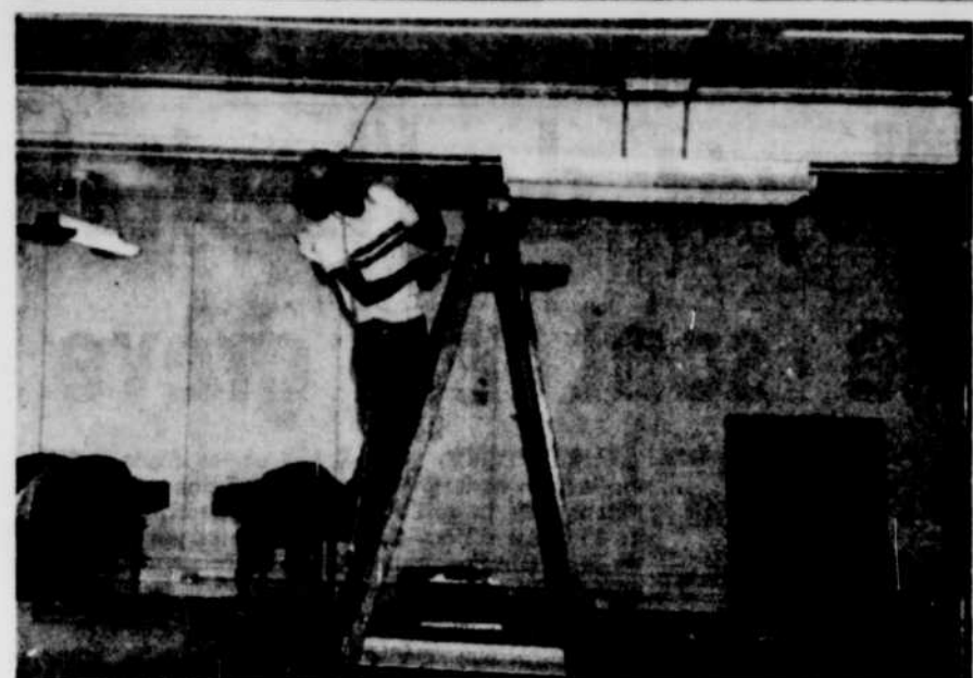
SOUVENIR DU PASSE. — Un électricien procède à l'enlèvement de certaines fixtures à l'ancien hôtel de ville d'Asbestos. Les employés ont déménagé leurs pénates hier dans le splendide édifice construit récemment. (Photo Marcel Laroché, Asbestos)
