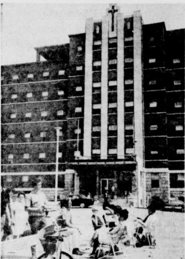
PIQUETAGE. — Le piquetage symbolique se poursuit aux abords de l'hôpital Ste-Croix où les employés sont en grève depuis samedi matin. Les grévistes n'ont pas encore arboré de pancartes; ils se contentent d'attendre... sur des chaises ou dans des automobiles, tout en surveillant les allées et venues des personnes qui se présentent sur le terrain.
