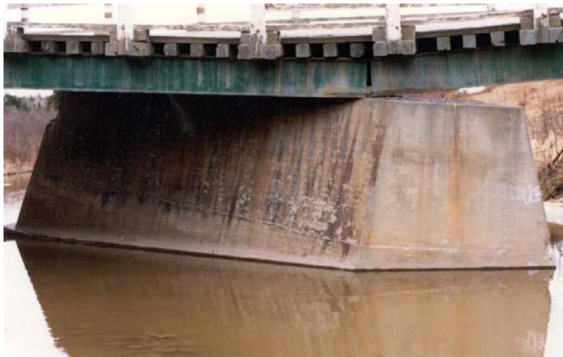
Photo 6.3.3 b) – Fondation superficielle d'une pile en béton armé
