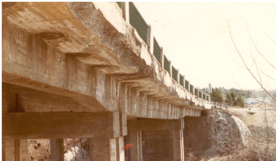
Photo 10.3.3 d) – Côté extérieur du tablier (platelage) d'un pont à trois travées
