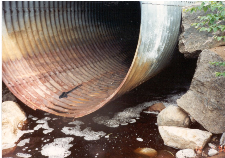
Photo 13.3.3 h) – Radier d'un ponceau en acier
