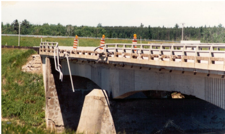
Photo 11.3.3 b) – Lisses et poteaux d'un dispositif de retenue
