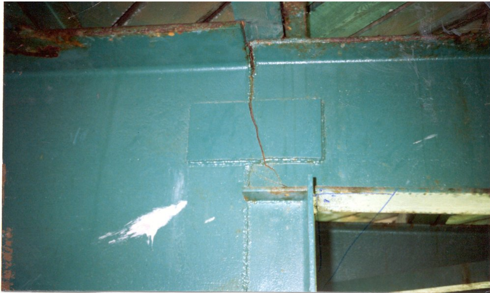
Photo 9.3.3 k) – Extrémité d'une poutre en acier
