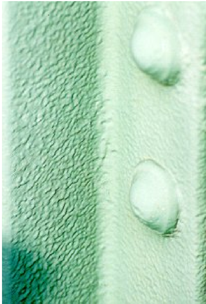
Photo 3.8.3 b) – Pulvérisation excessive
