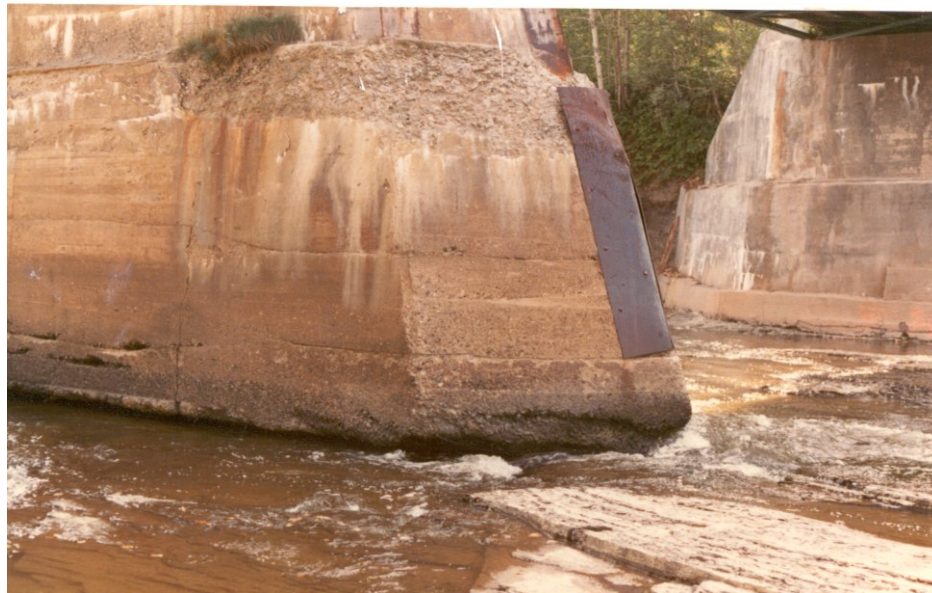
Photo 6.3.3 d) – Fondation superficielle d'une pile en béton armé - semelle et sol sous-jacent
