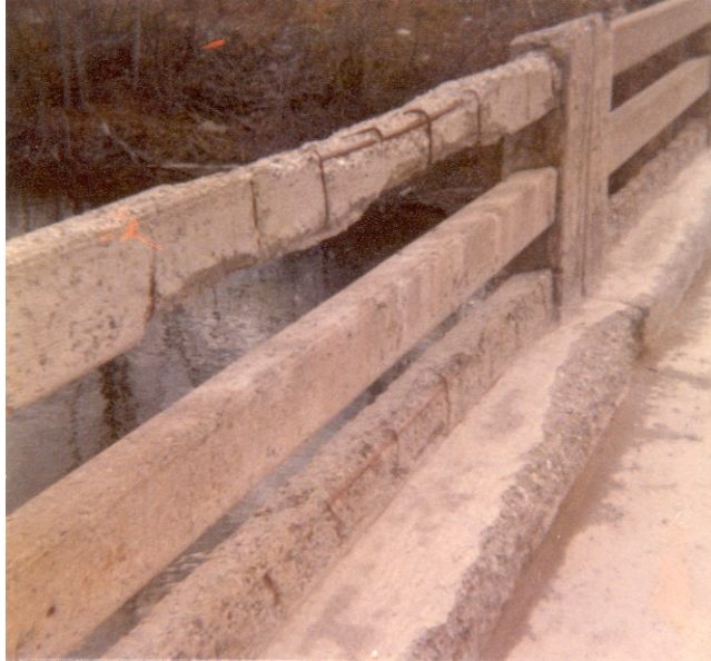
Photo 11.3.3 e) – Lisses d'un dispositif de retenue en béton armé
