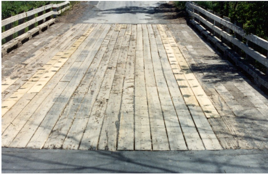
Photo 10.4.3 c) – Surface de roulement en bois
