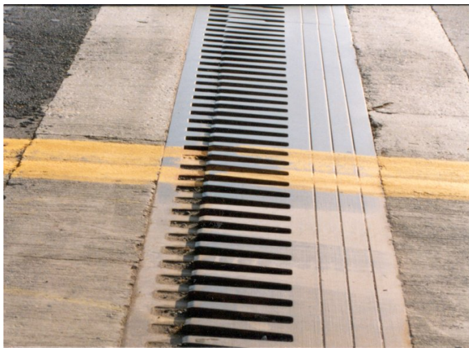
Photo 8.3.3 b) – Dents d'un joint à dents
