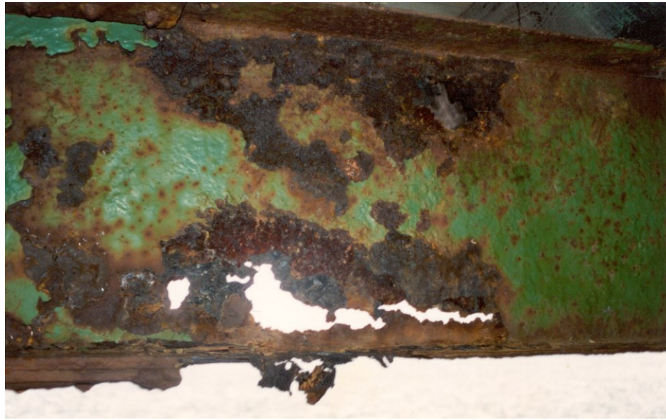
Photo 9.3.3 i) – Centre d'une poutre en acier
