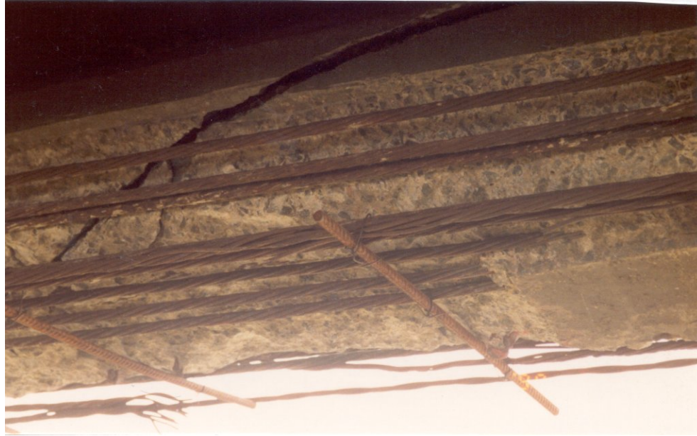
Photo 9.3.3 e) – Extrémité d'une poutre en béton précontraint
