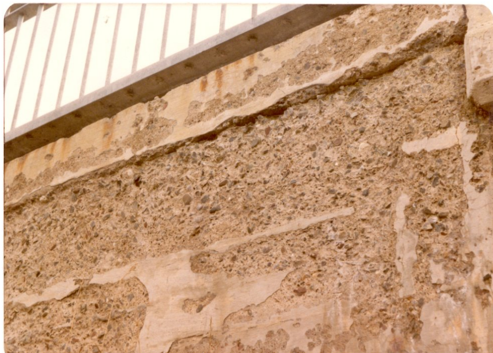
Photo 3.2.1 b) – Écaillage moyen du côté extérieur d'un pont
