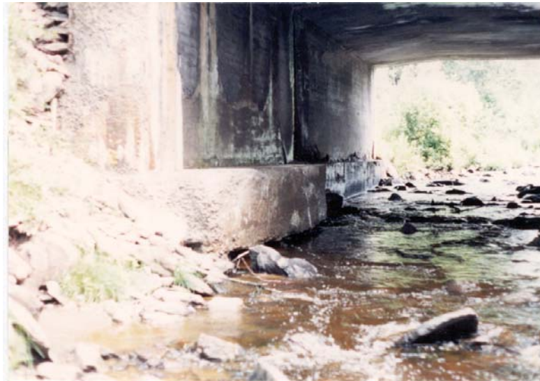
Photo 4.3.3 a) – Cours d'eau - fondation superficielle
