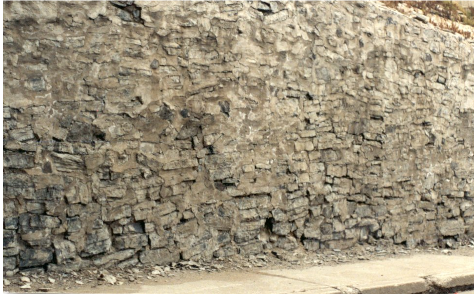
Photo 6.4.3 e) – Mur de maçonnerie
