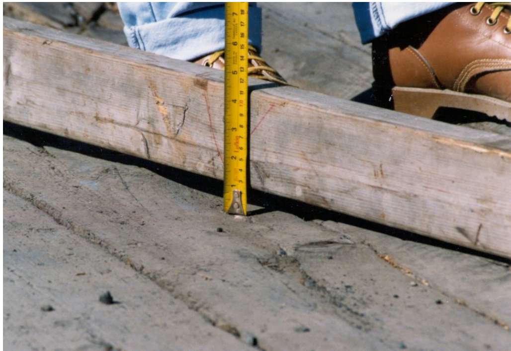
Photo 3.4.5 b) – Usure très importante d'un platelage
