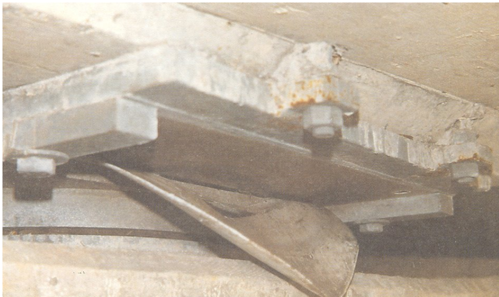
Photo 7.3.3 f) – Appareil à élastomère confiné
