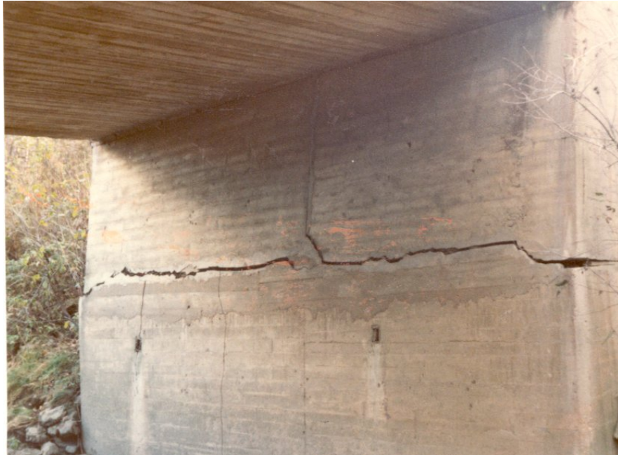
Photo 6.3.3 i) – Mur de front d'une culée en béton
