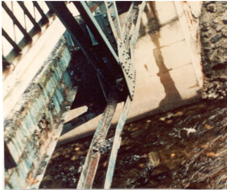
Photo 9.3.3 m) – Membrane inférieure d'une poutre triangulée
