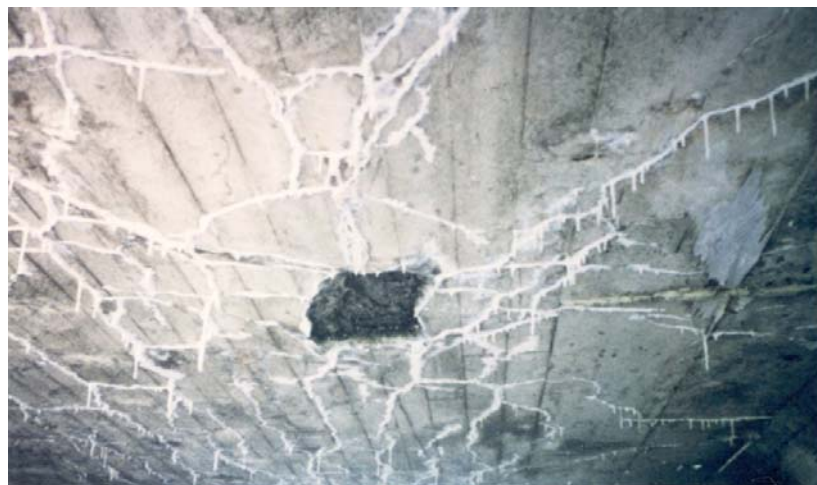
Photo 10.3.3 b) – Dessous au centre d'une dalle sur poutres en béton armé
