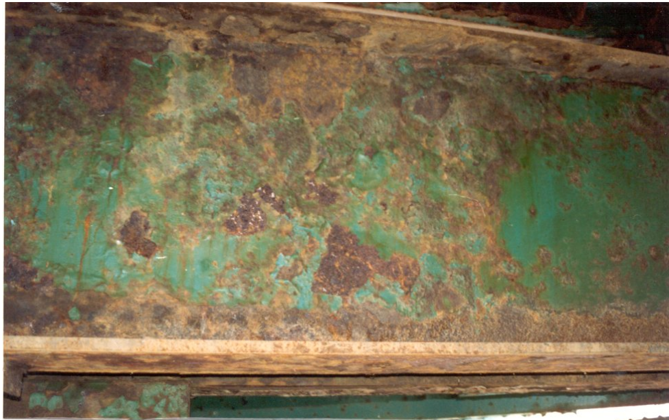
Photo 9.3.3 j) – Extrémité d'une poutre en acier
