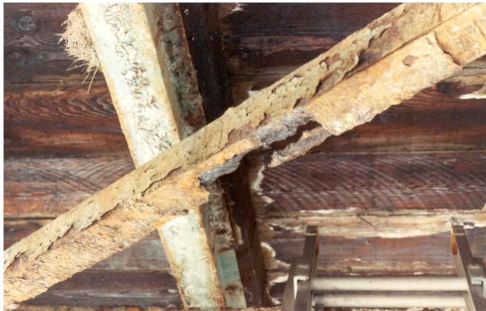
Photo 9.4.3 d) – Contreventement inférieur de la structure de tablier
