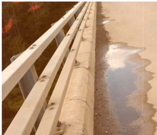
Photo 10.5.3 b) – Drainage et système de drainage sur le tablier
