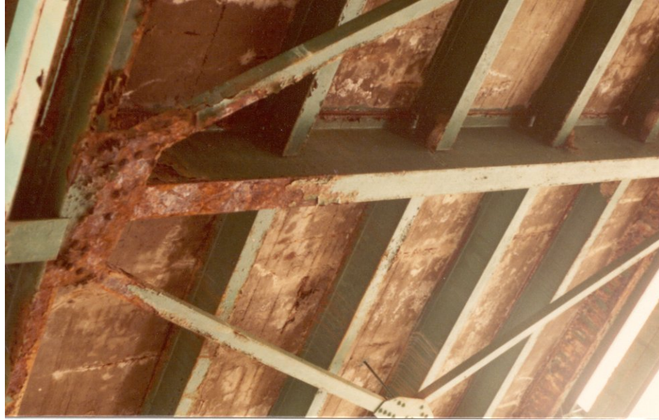
Photo 9.4.3 e) – Contreventements inférieurs (assemblage) de la structure de tablier
