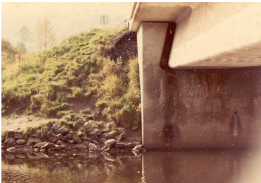
Photo 5.4.3 d) – Remblai d'approche
