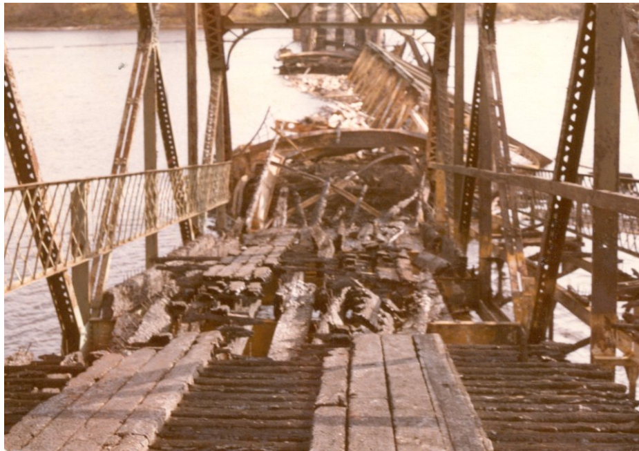
Photo 3.4.4 b) – Bois calciné de façon importante
