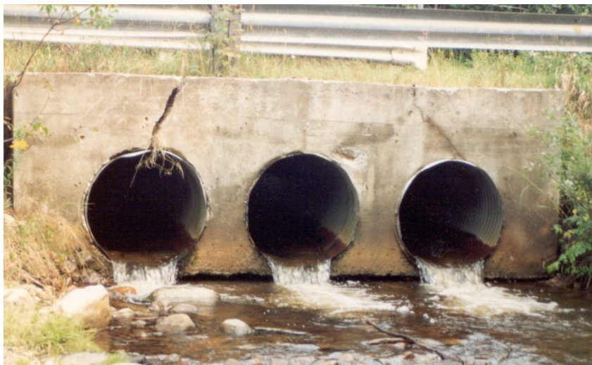
Photo 13.4.3 b) – Mur de tête en béton d'un ponceau
