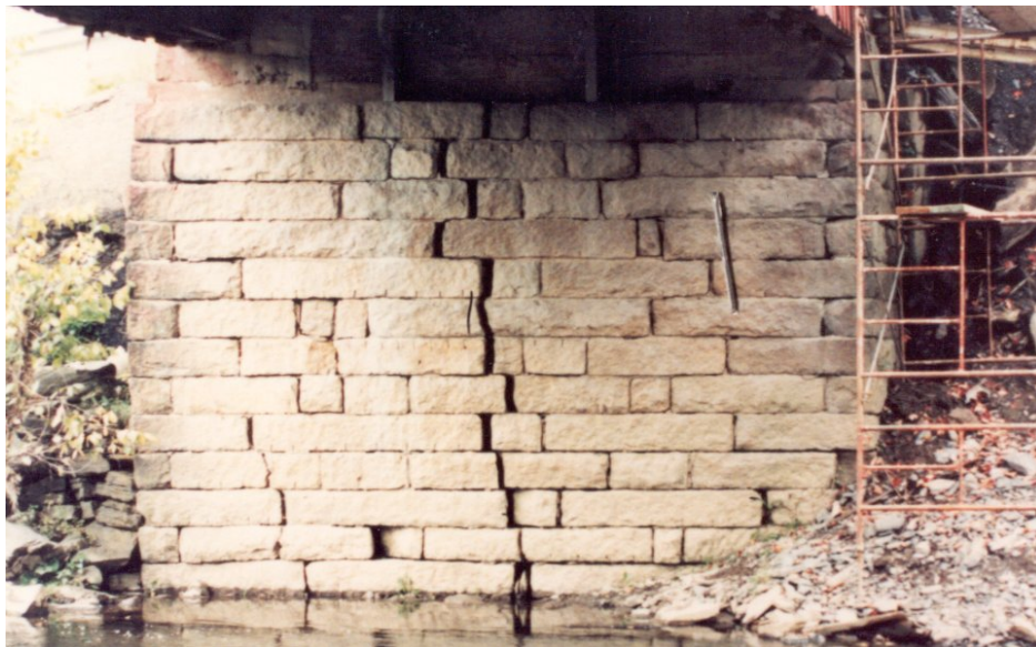
Photo 6.3.3 j) – Mur de front d'une culée en maçonnerie sèche
