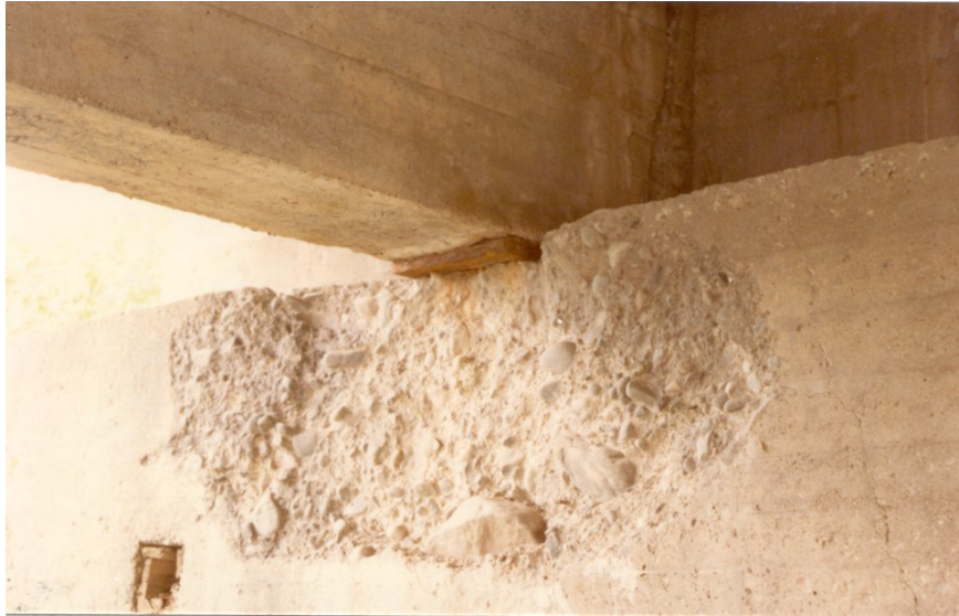
Photo 6.4.3 a) – Assise d'une culée
