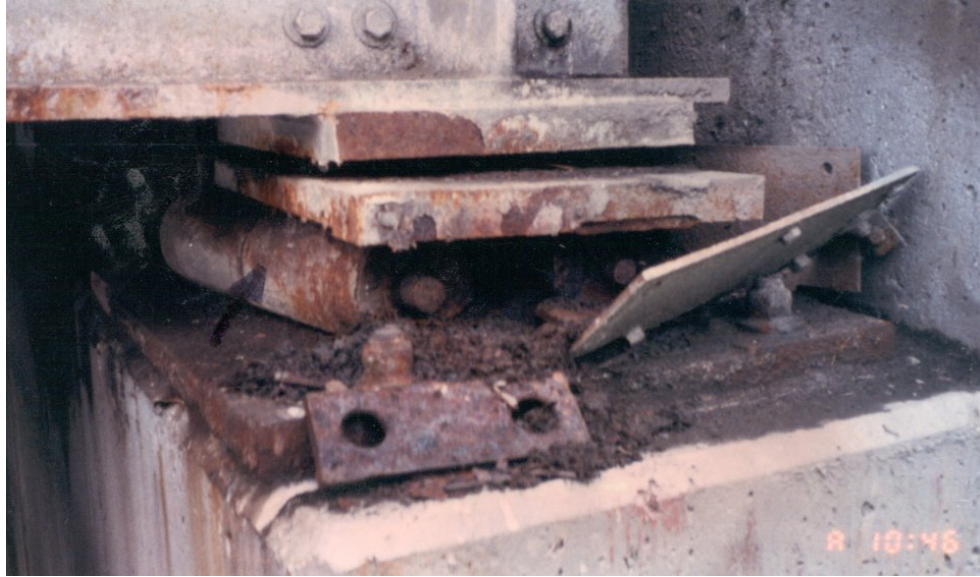
Photo 7.3.3 g) – Appareil à rouleaux
