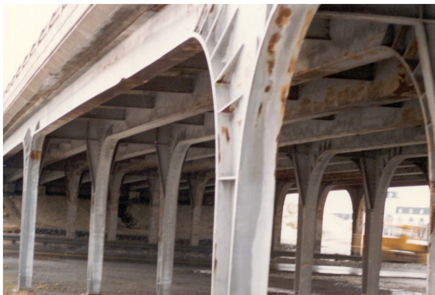
Photo 12.3.3 g) – Revêtement des colonnes d'une béquille intermédiaire – éléments principaux
