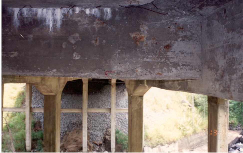
Photo 9.4.3 c) – Diaphragme intermédiaire en béton armé
