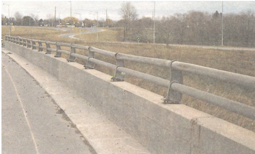
Photo 11.3.3 a) – Poteaux d'un dispositif de retenue
