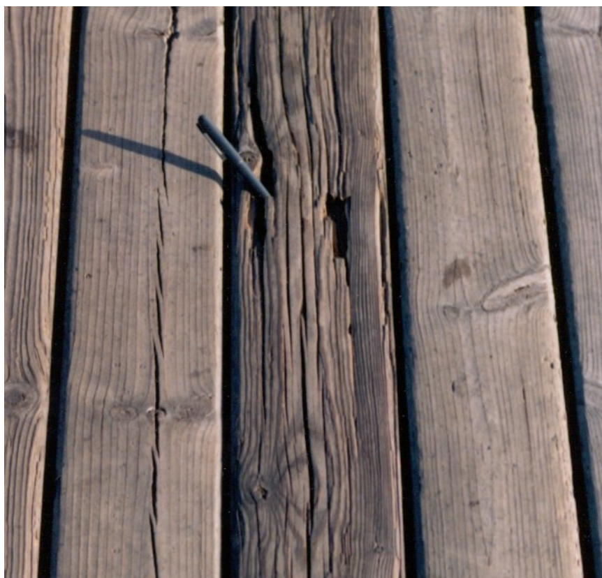
Photo 3.4.2 b) – Pourriture moyenne d'une pièce
