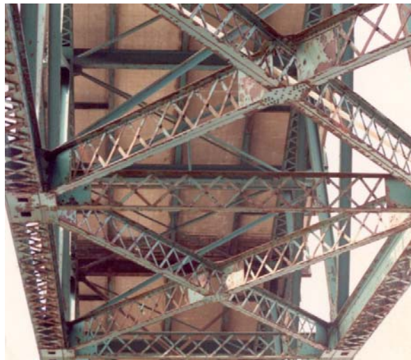
Photo 9.4.3 b) – Contreventements inférieurs des poutres triangulées
