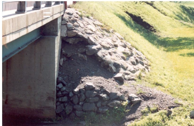
Photo 5.4.3 b) – Remblai d'approche
