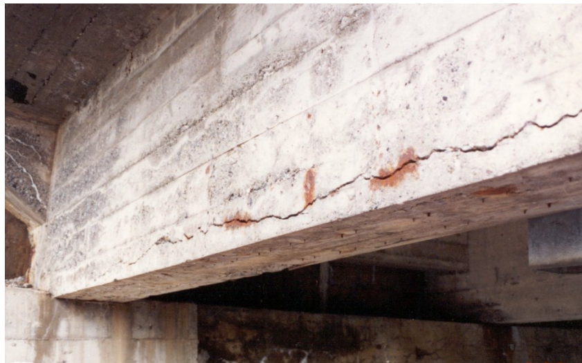
Photo 9.3.3 b) – Milieu et extrémité d'une poutre en béton armé
