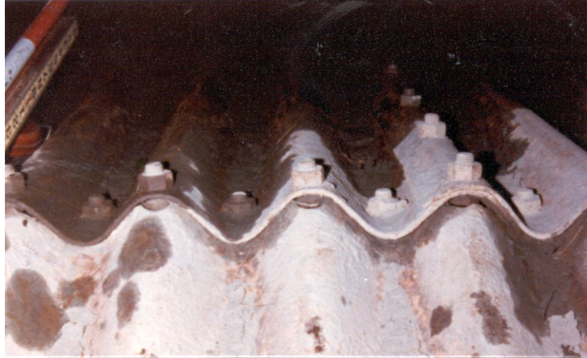
Photo 13.3.3 g) – Radier d'un ponceau en acier
