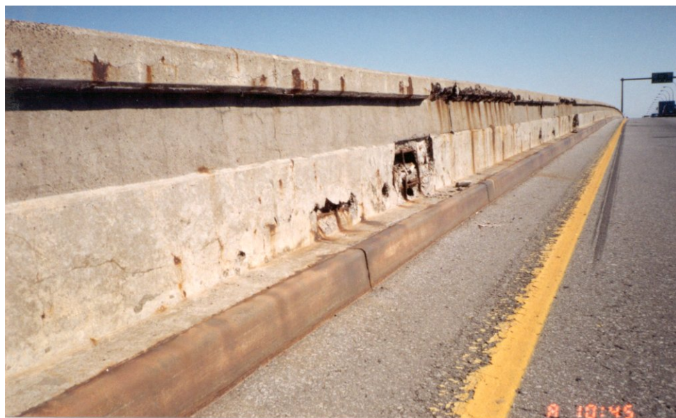
Photo 11.3.3 c) – Glissière latérale en béton armé
