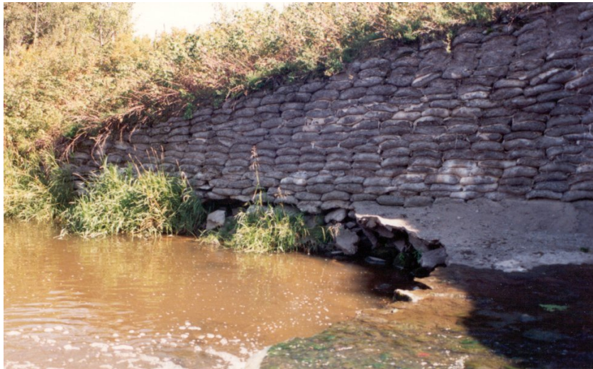
Photo 13.4.3 a) – Mur en aile en sacs de sable-ciment d'un ponceau
