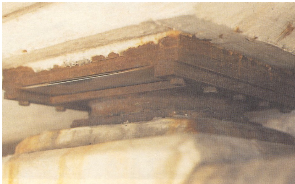
Photo 7.3.3 d) – Appareil avec articulation sphérique
