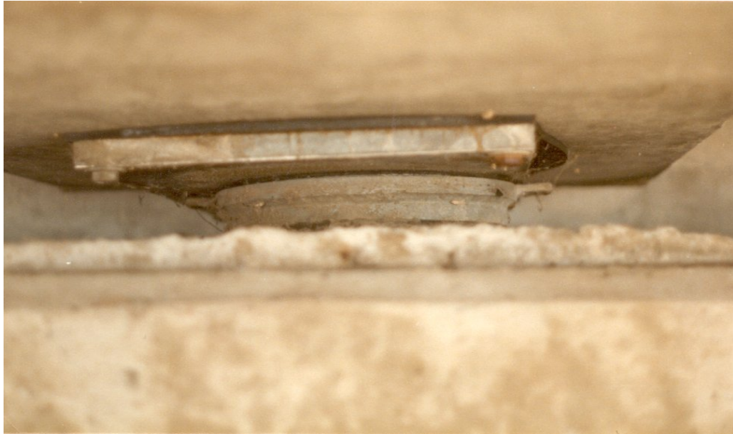
Photo 7.3.3 e) – Appareil avec articulation sphérique
