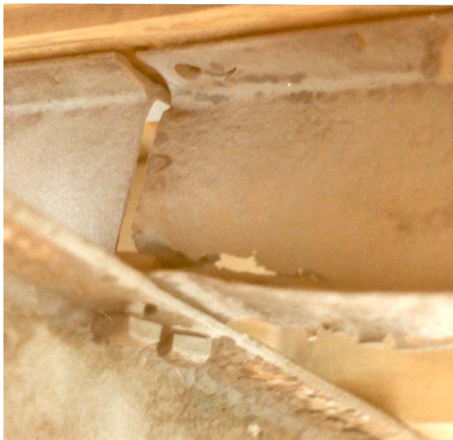
Photo 9.3.3 l) – Longeron d'un panneau intermédiaire en acier d'un tablier d'un pont à poutres triangulées
