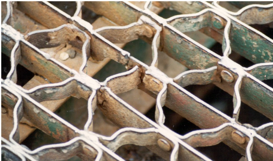
Photo 10.3.3 f) – Dessous de l'extrémité d'un platelage - caillebotis
