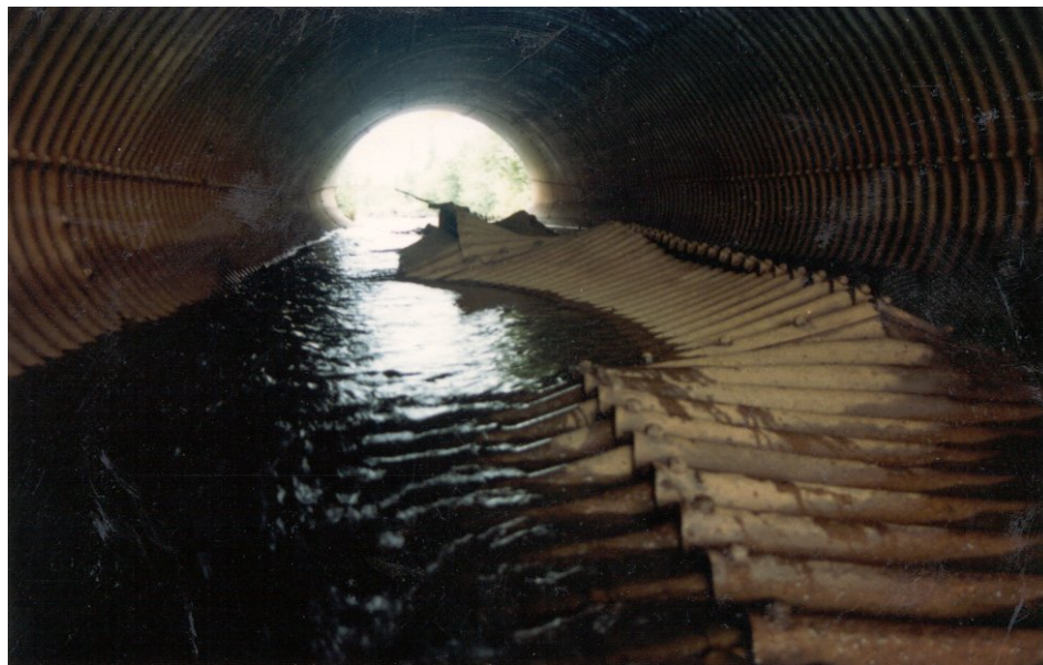
Photo 13.3.3 d) – Radier d'un ponceau en acier
