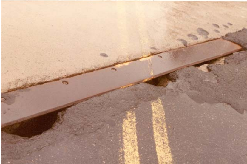
Photo 8.3.3 a) – Plaque d'un joint à plaques
