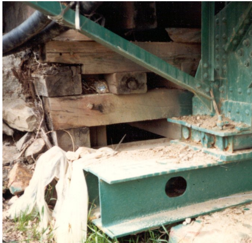
Photo 3.4.6 b) – Extrémité d'une pièce écrasée
