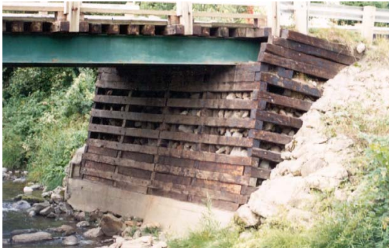
Photo 6.3.3 a) – Fondation superficielle d'un caisson à claire-voie - semelle de béton et sol sous-jacent
