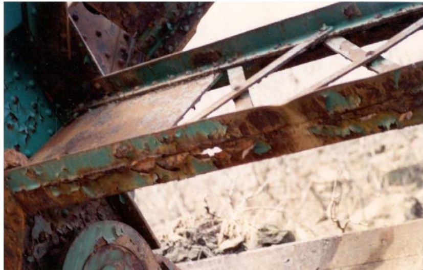
Photo 9.4.3 a) – Contreventement inférieur des poutres triangulées
