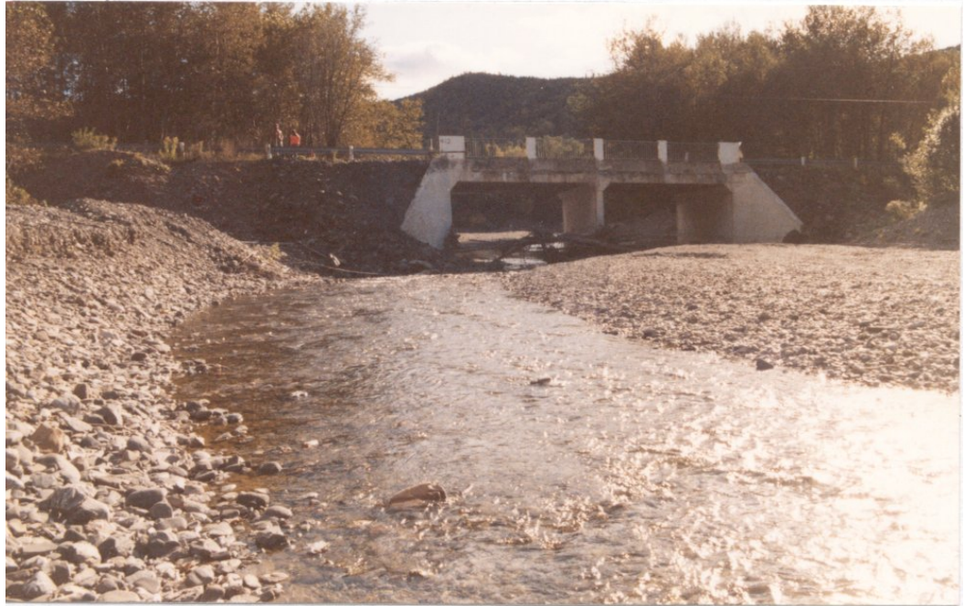
Photo 4.3.3 e) – Cours d'eau - fondation superficielle
