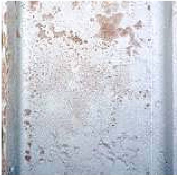
Photo 3.8.3 c) – Piqûres de rouille
