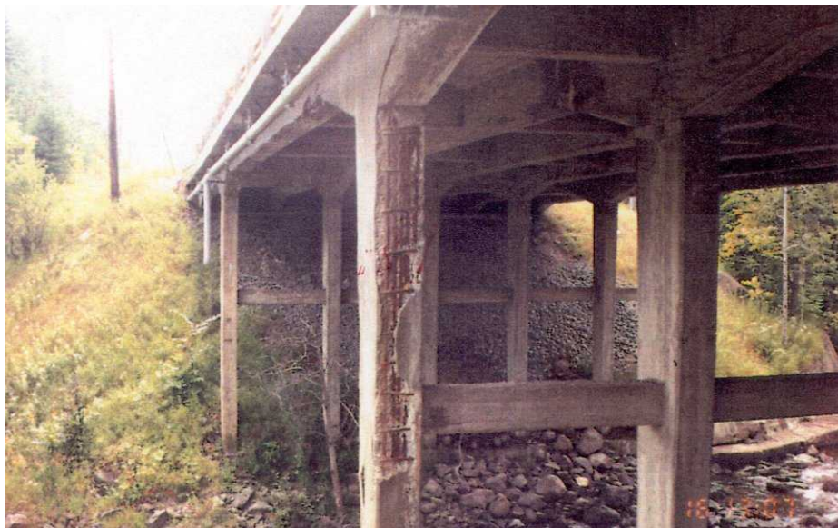
Photo 6.3.3 p) – Colonnes d'une béquille intermédiaire en béton armé
