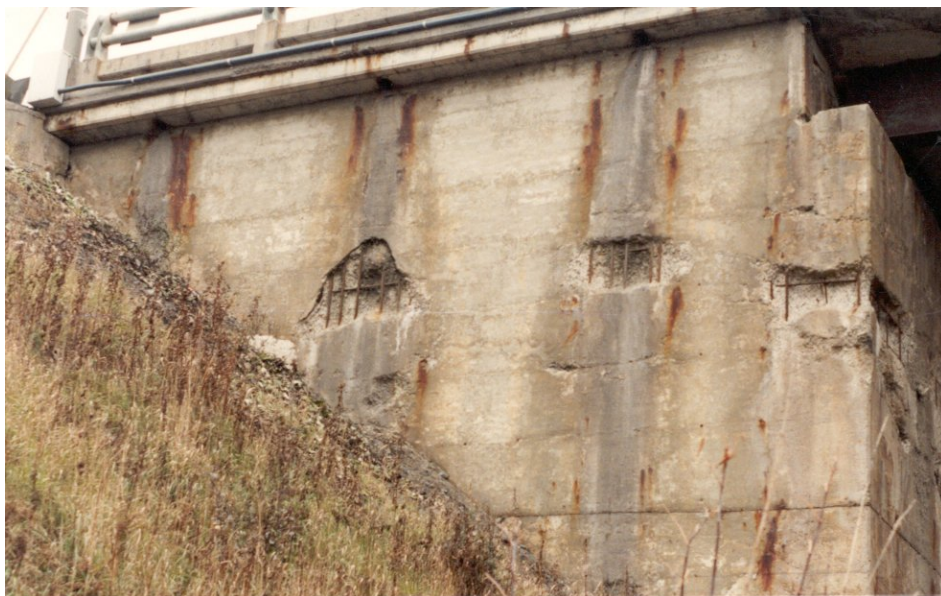
Photo 6.4.3 d) – Mur en retour en béton armé d'une culée
