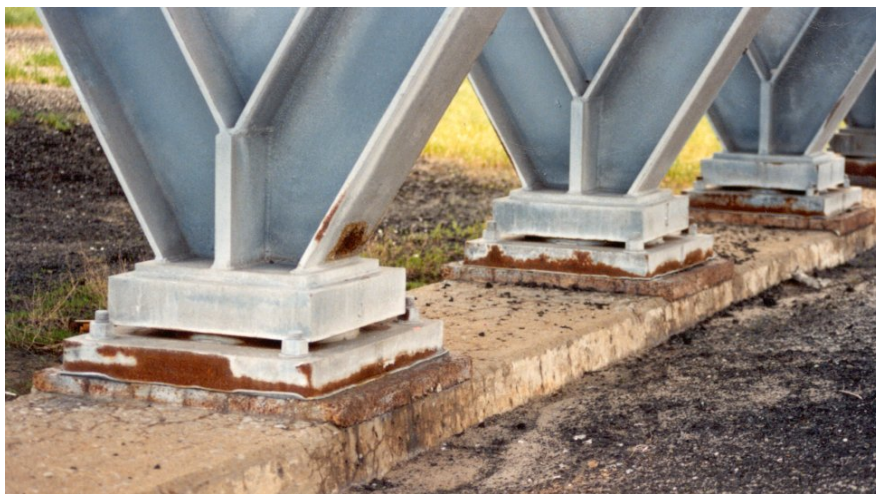
Photo 6.4.3 b) – Assise d'une béquille intermédiaire
