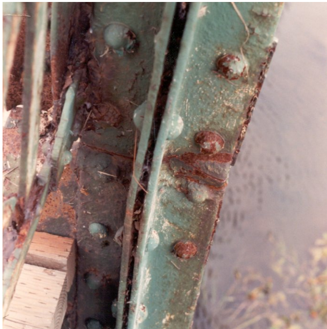
Photo 9.3.3 n) – Montant d'une poutre triangulée
