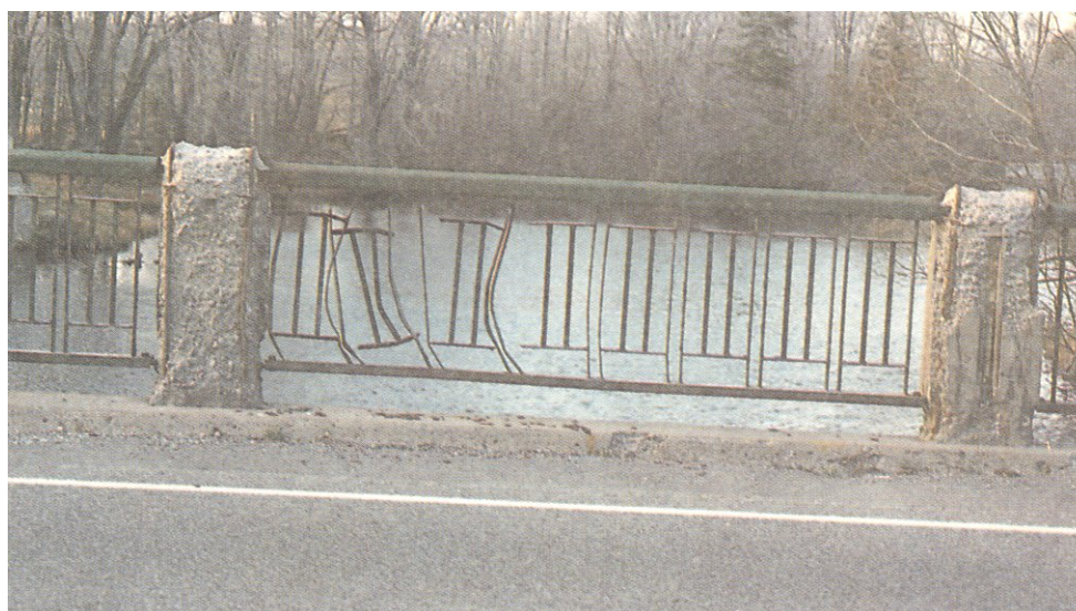
Photo 11.3.3 d) – Poteaux d'un dispositif de retenue
