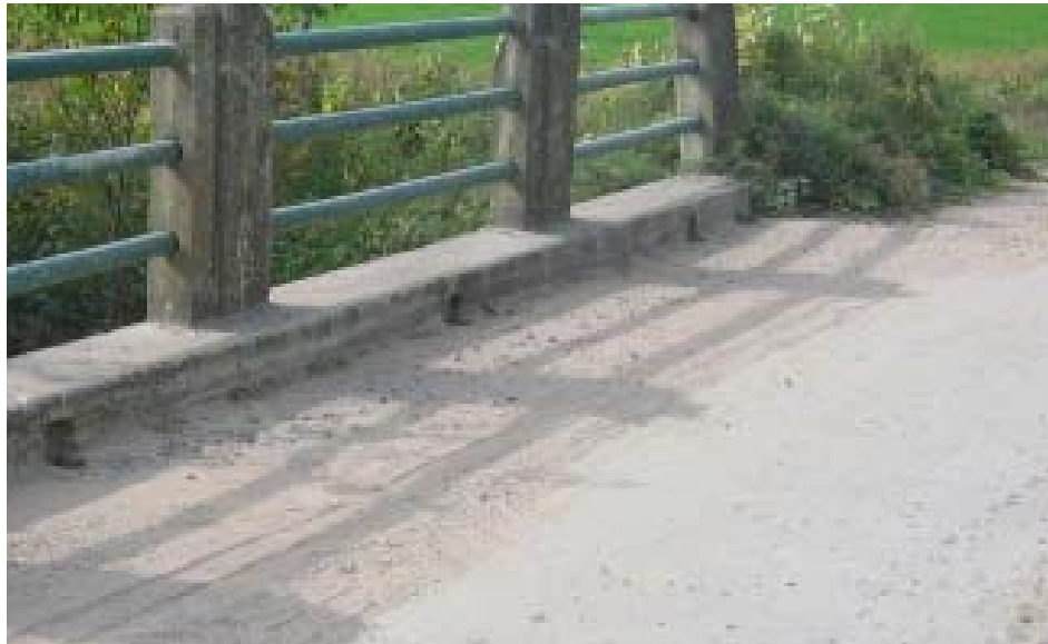
Photo 10.3.3 c) – Dessus de la dalle sur poutres en béton
