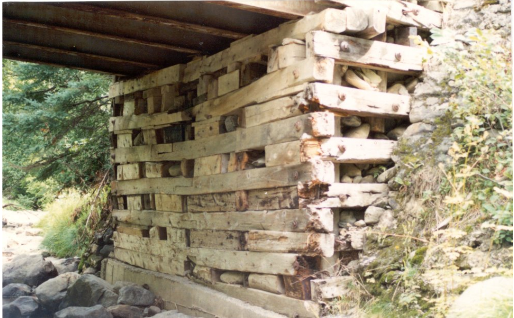
Photo 6.3.3 k) – Mur de front d'un caisson à claire-voie en bois
