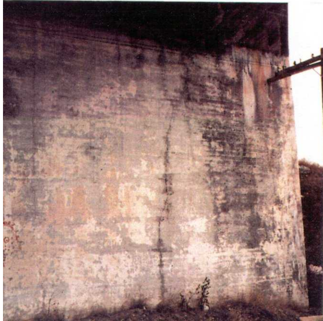
Photo 6.3.3 o) – Mur de front d'une béquille de portique en béton armé
