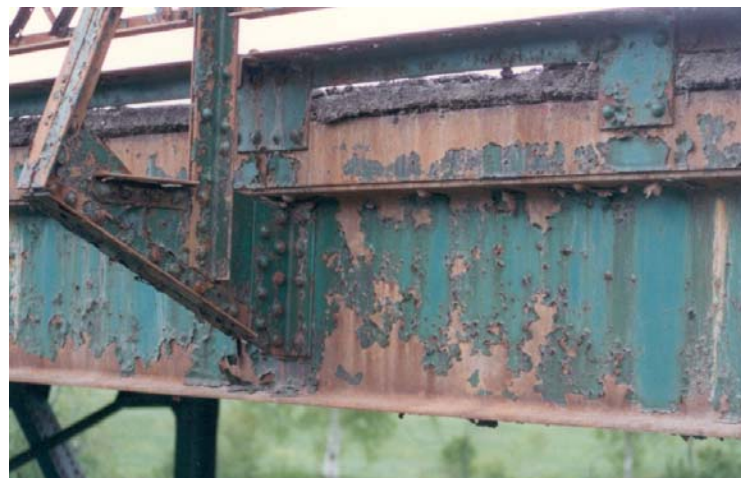
Photo 12.3.3 b) – Revêtement du milieu d'une poutre à âme pleine de rive – élément principal
