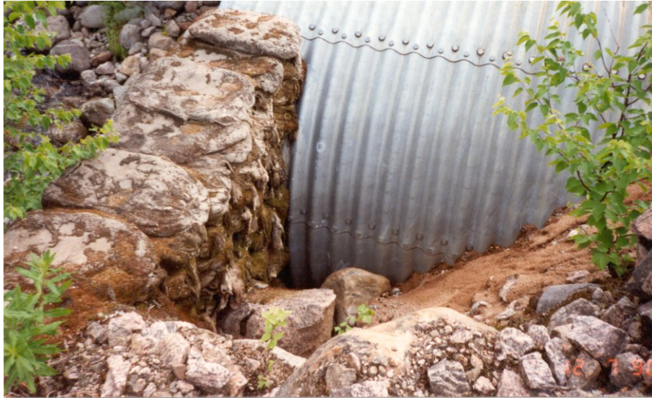
Photo 13.4.3 c) – Mur de tête en sacs de sable-ciment d'un ponceau
