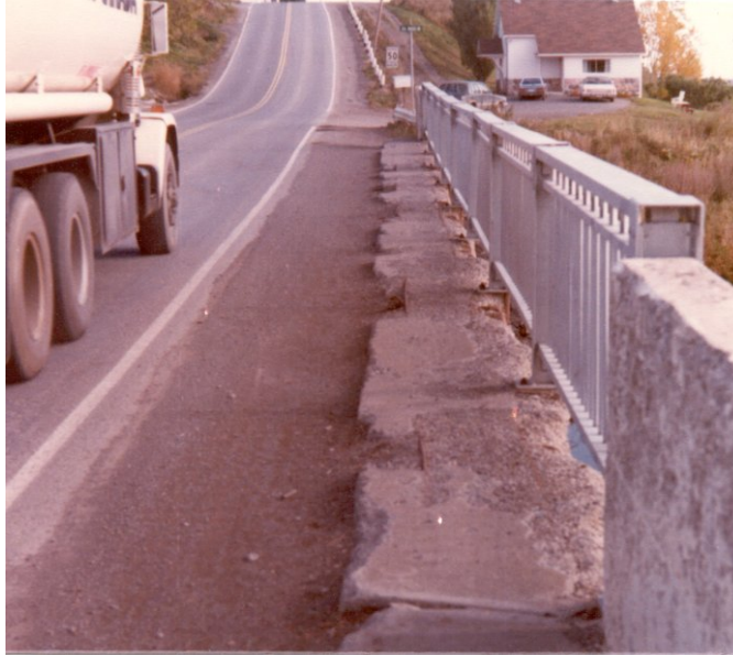
Photo 10.4.3 e) – Chasse-roue en béton
