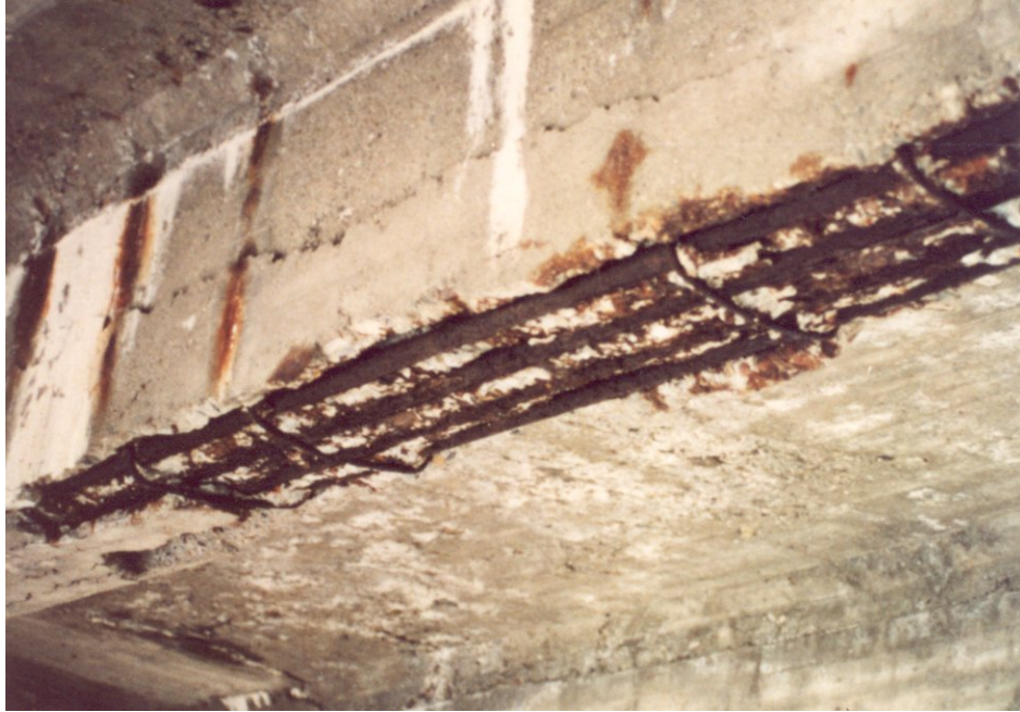
Photo 9.3.3 c) – Milieu d'une poutre en béton armé
