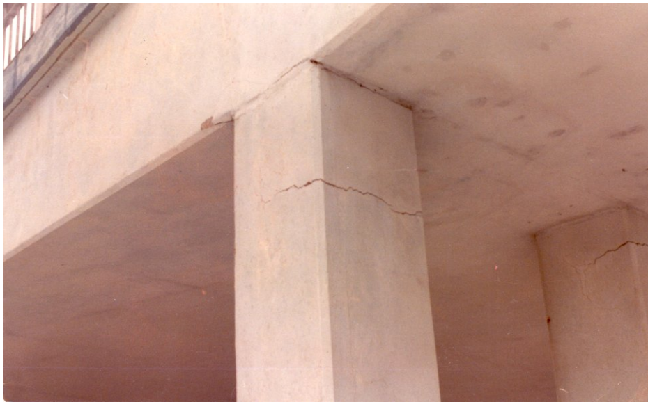
Photo 6.3.3 h) – Colonnes d'une béquille intermédiaire en béton armé
