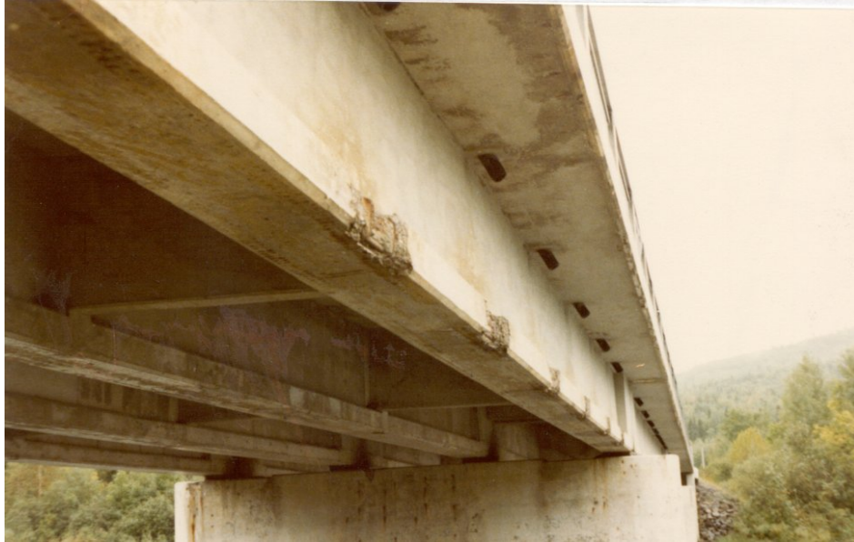
Photo 10.5.3 c) – Drainage et système de drainage sur le tablier
