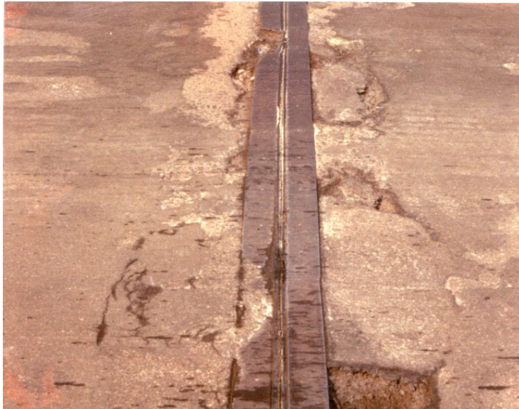
Photo 8.3.3 d) – Épaulements d'un joint à garniture comprimée
