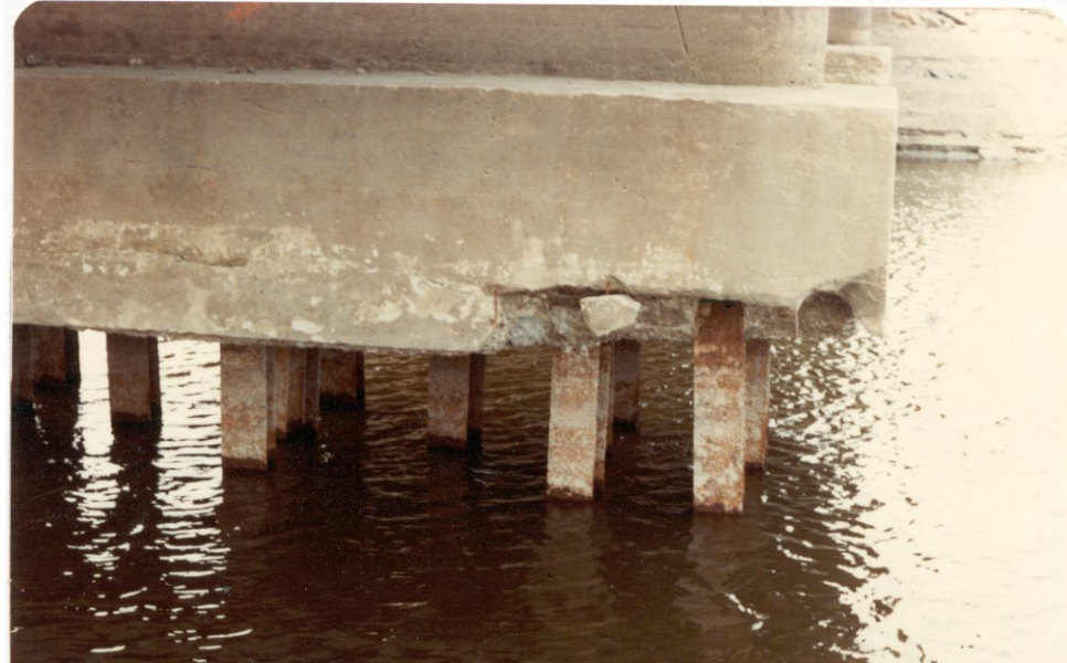
Photo 6.3.3 c) – Fondation d'une pile en béton armé - semelle sur pieux en acier
