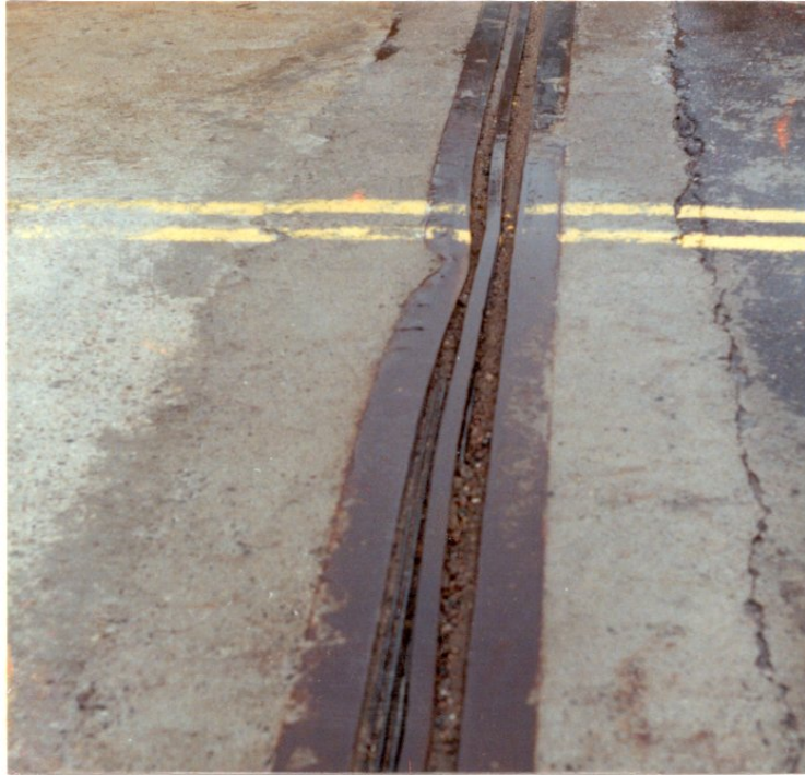
Photo 8.3.3 c) – Cornières d'un joint à garnitures comprimées double module
