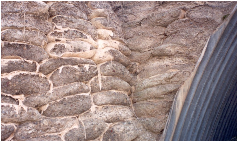
Photo 13.3.3 d) – Mur en aile et mur de tête en sacs de sable-ciment d'un ponceau
