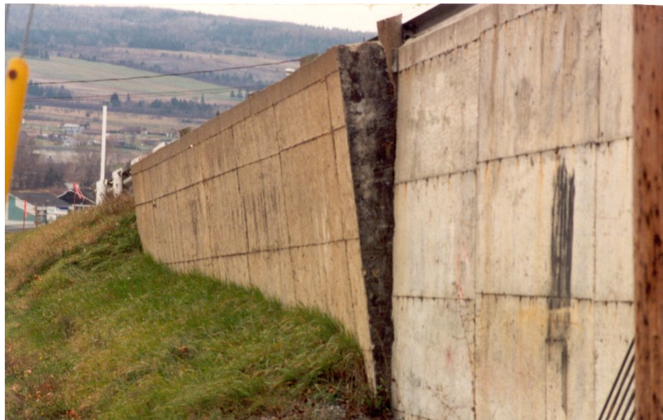
Photo 6.4.3 f) – Mur de soutènement en béton armé d'une culée (< 150 m 2 )
