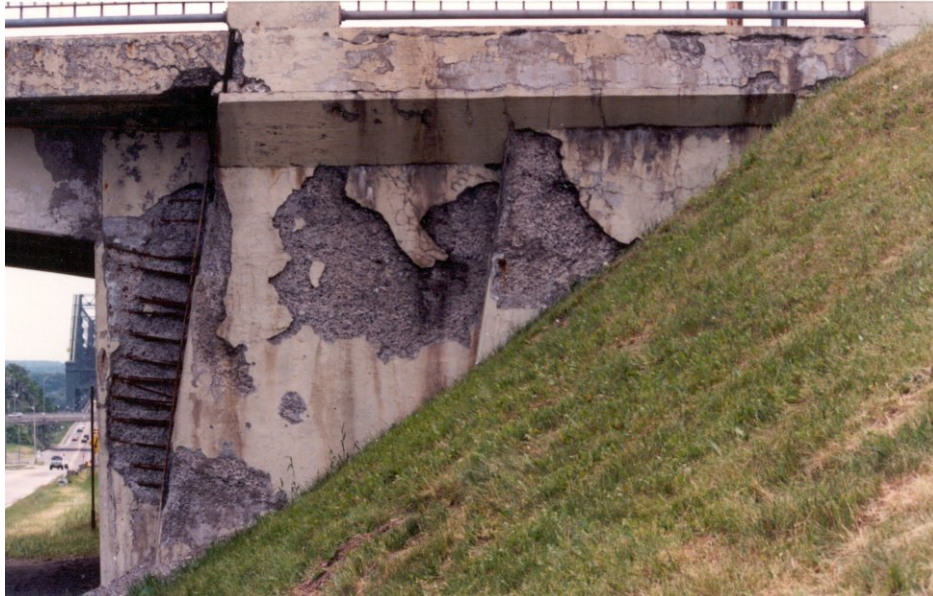
Photo 6.4.3 c) – Mur en retour en béton armé d'une bécuille de portique
