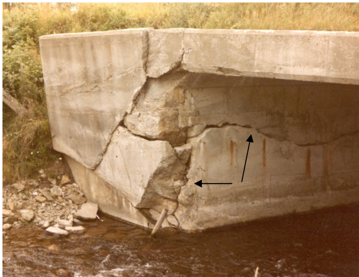
Photo 13.3.3 b) – Mur d'un ponceau en béton armé
