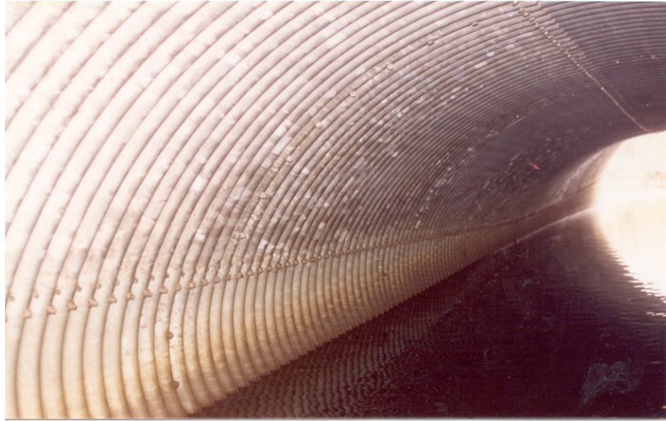
Photo 13.3.3 c) – Fondation d'un ponceau en acier
