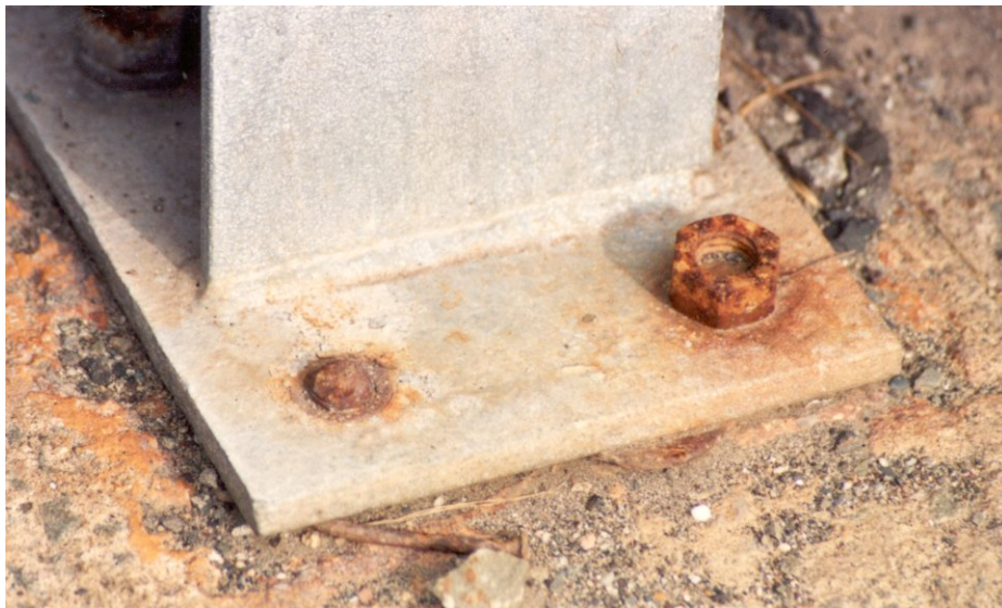
Photo 11.3.3 f) – Poteau d'un dispositif de retenue
