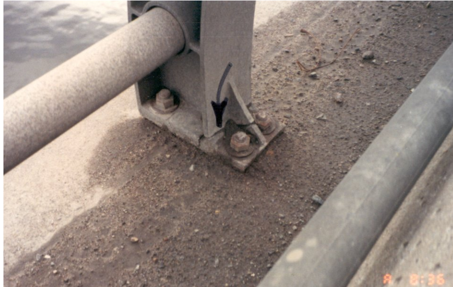
Photo 11.3.3 g) – Poteau d'un dispositif de retenue
