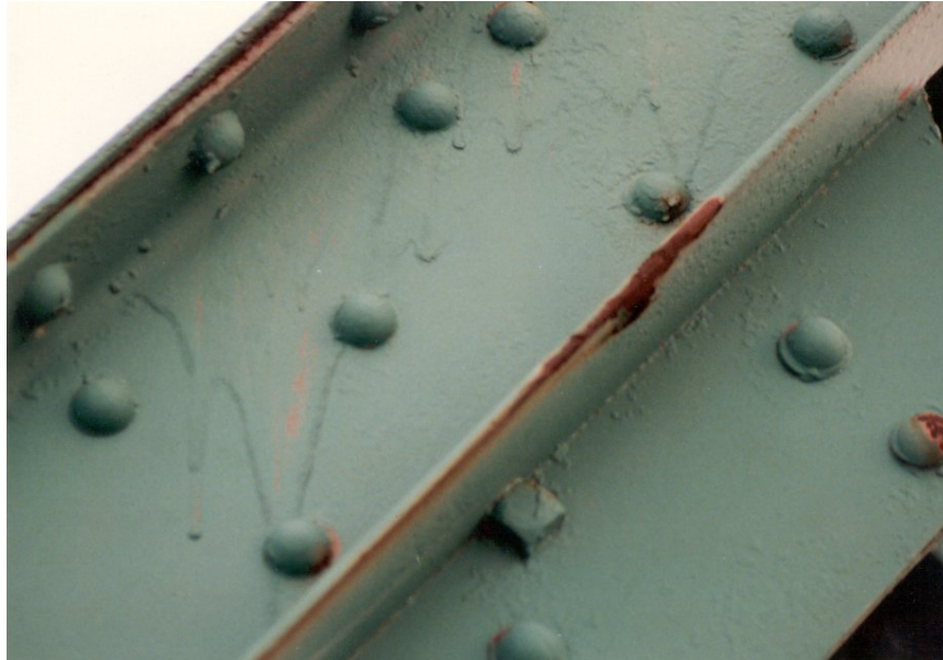
Photo 12.3.3 e) – Revêtement des diagonales d'une poutre triangulée – éléments principaux
