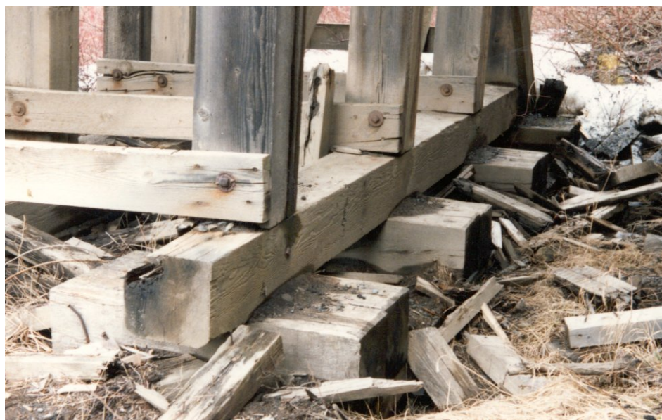
Photo 6.3.3 n) – Fondation d'un banc en bois - semelle et sol sous-jacent
