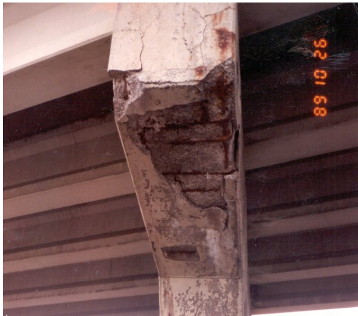
Photo 6.3.3 f) – Chevêtre d'une pile en béton armé
