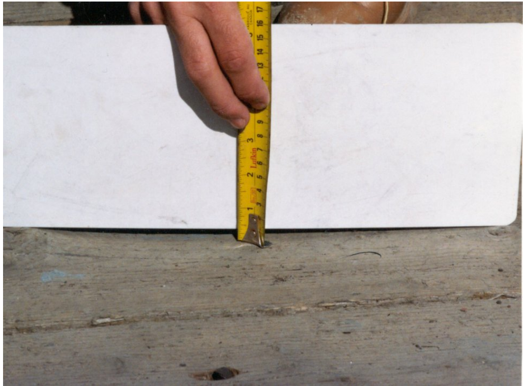
Photo 3.4.5 a) – Usure légère d'un platelage
