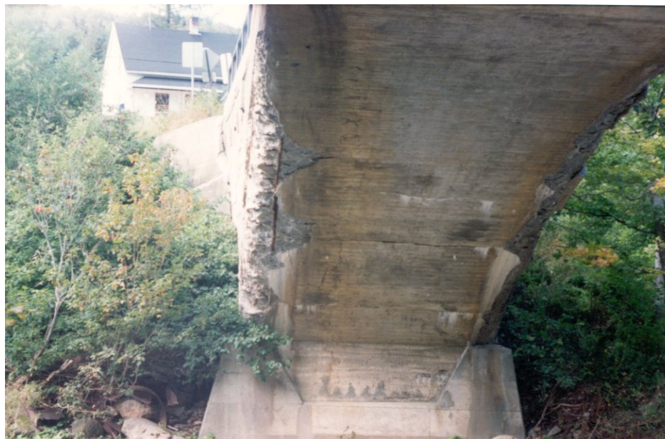
Photo 9.3.3 h) – Rein d'un arc en béton
