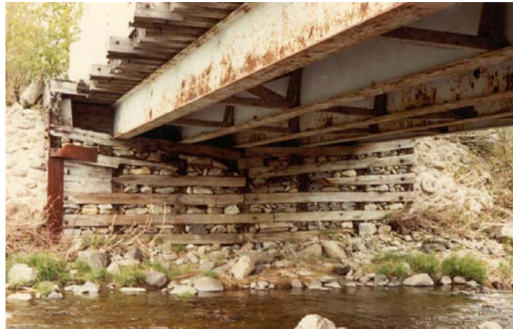
Photo 12.3.3 a) – Revêtement du milieu d'une poutre à âme pleine – élément principal
