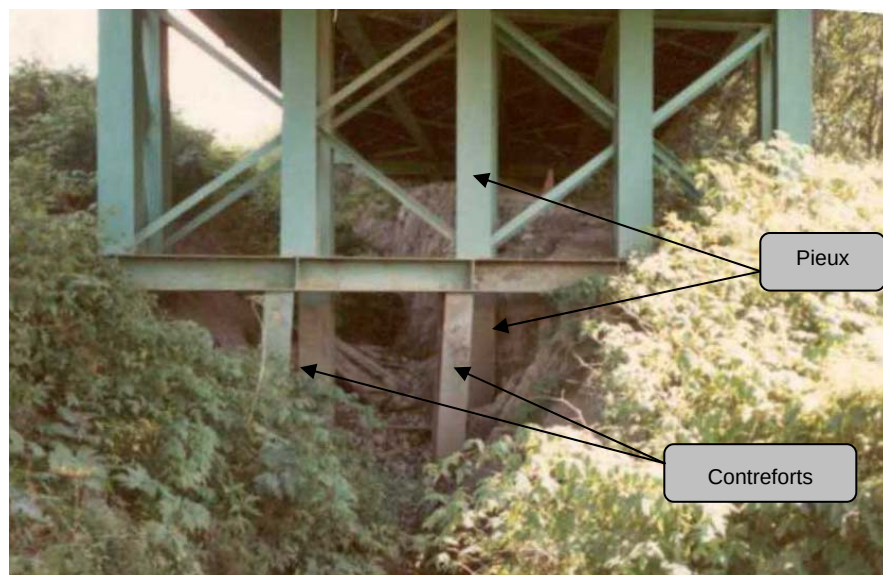
Photo 6.3.3 m) – Fondation d'un banc en acier - pieux et sol adjacent
