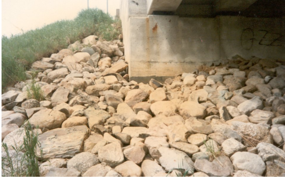
Photo 5.4.3 c) – Remblai d'approche
