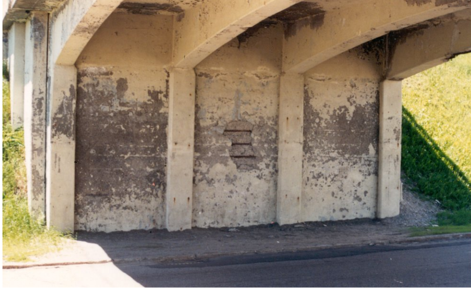
Photo 6.3.3 e) – Mur de front d'une béquille de portique en béton armé
