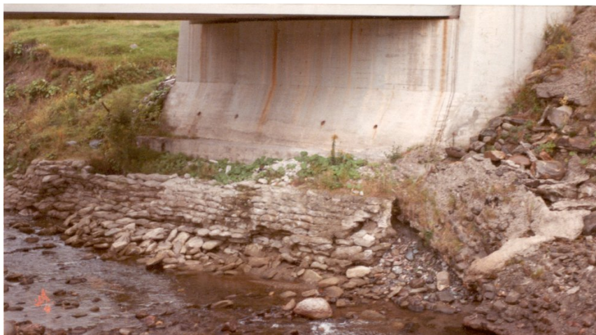
Photo 4.3.3 b) – Cours d'eau - fondation superficielle
