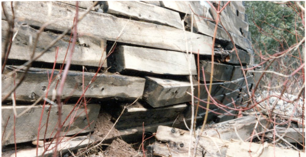
Photo 6.3.3 l) – Mur de front d'un caisson à claire-voie en bois
