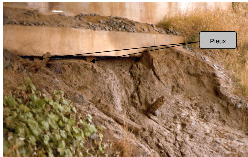
Photo 5.4.3 a) – Remblai d'approche d'une fondation sur pieux
