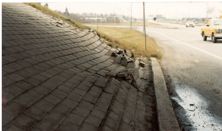
Photo 5.5.3 b) – Protection de talus en pavés de béton
