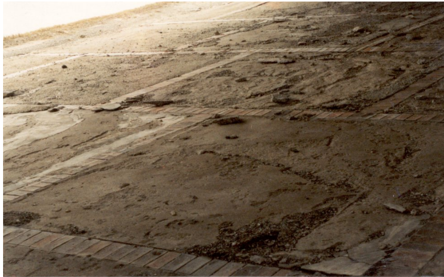
5.5.3 a) – Protection de talus en béton
