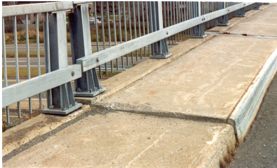
Photo 10.4.3 f) – Trottoir en béton
