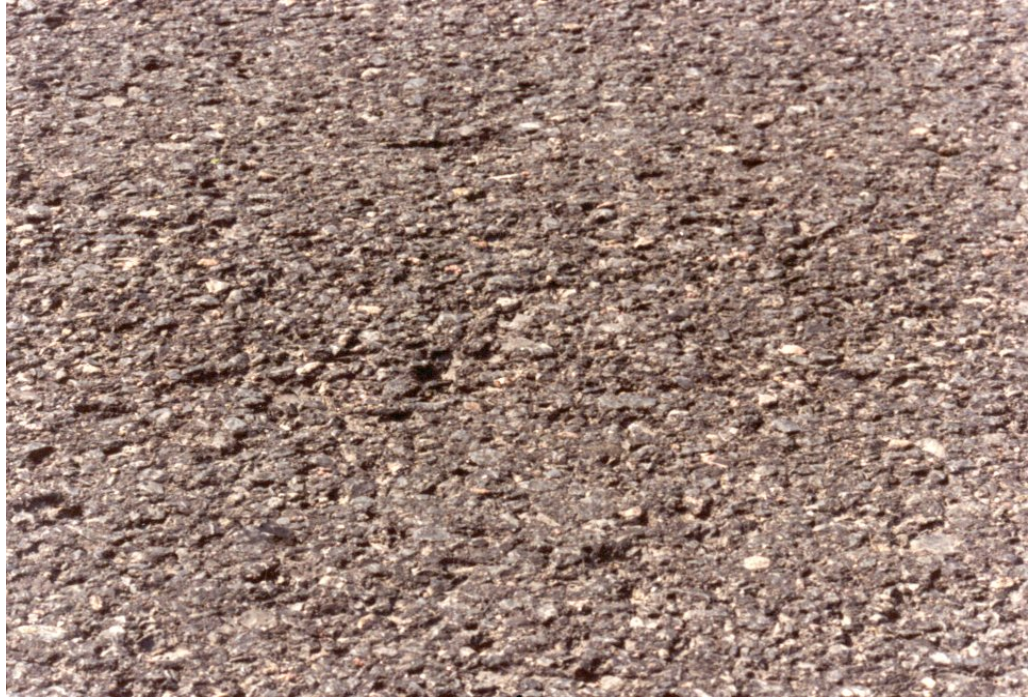
Photo 3.7.2 a) – Désenrobage et arrachement léger
