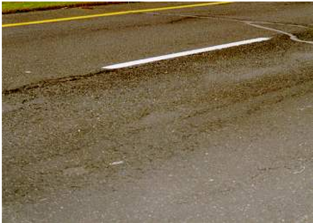
Photo 3.7.2 b) – Désenrobage et arrachement moyen
