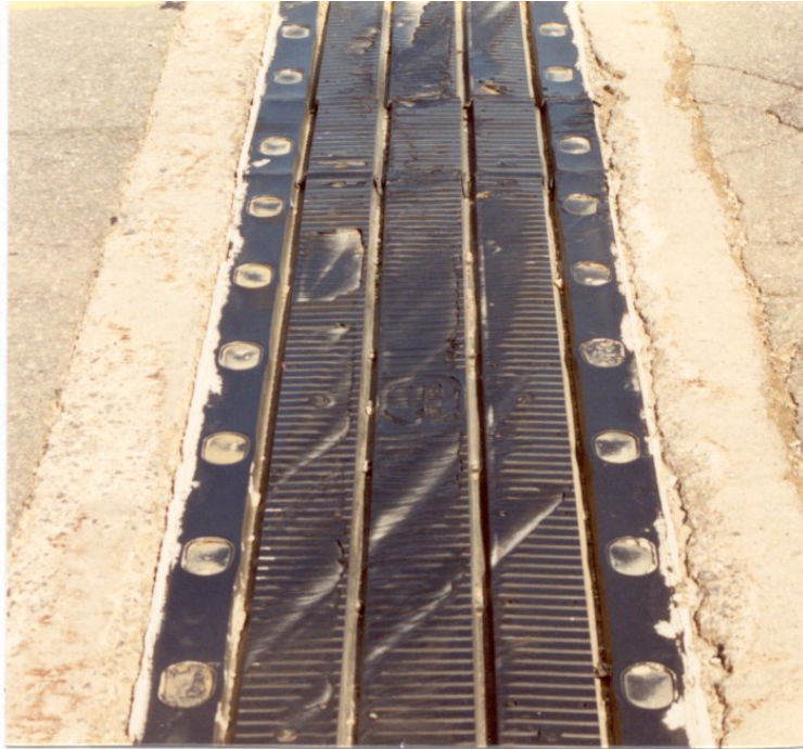
Photo 8.3.3 g) – Plaque d'un joint à plaque en élastomère fretté
