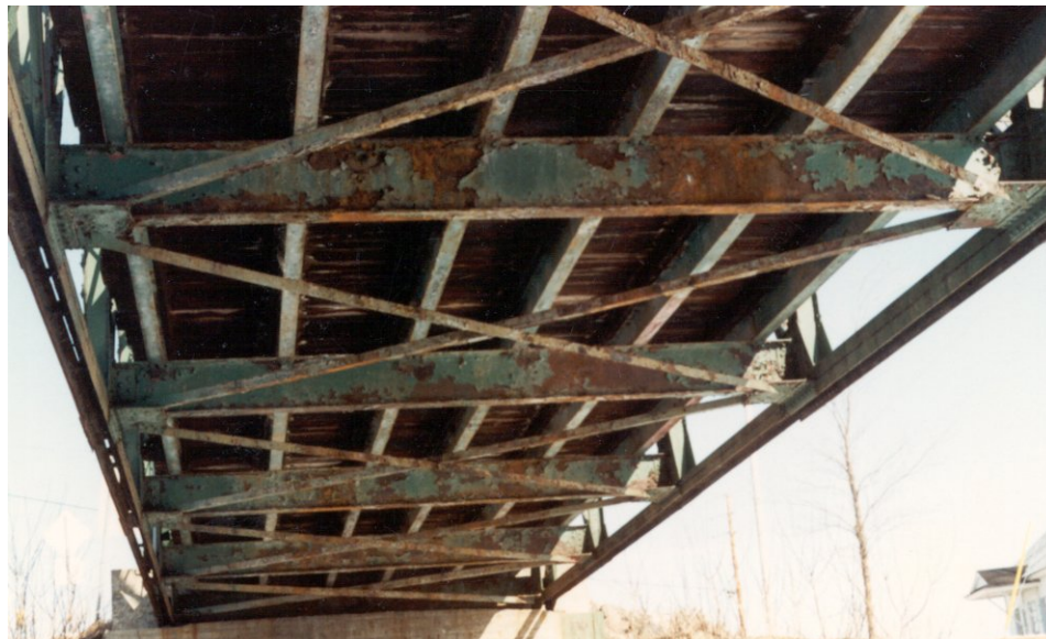
Photo 12.3.3 d) – Revêtement des entretoises intermédiaires de la structure de tablier – éléments principaux
