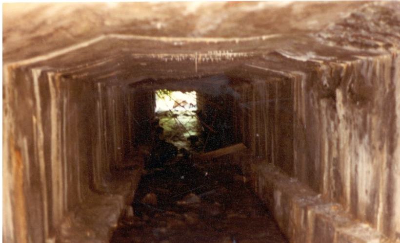
Photo 13.3.3 a) – Dessous de la dalle d'un ponceau
