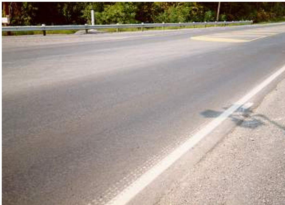
Photo 3.7.8 – Polissage de la surface
