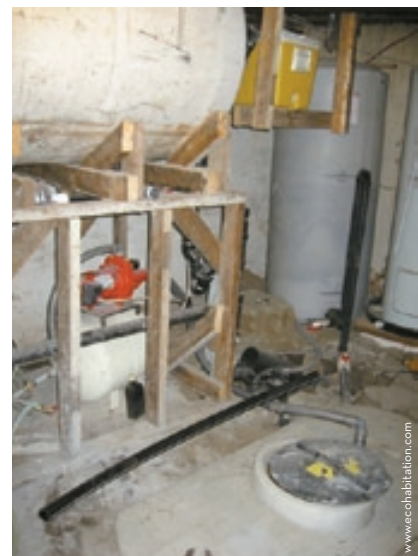
📍 Écohabitation maison LEED : Le système d'eaux grises filtre l'eau des bains, douches et lessiveuses pour la réutilisation dans les toilettes et l'irrigation du toit vert.
