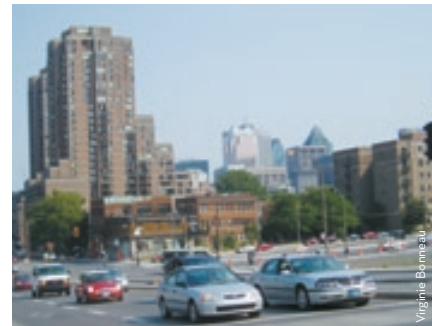
1 Après : intersection du Parc / des Pins réaménagée.
