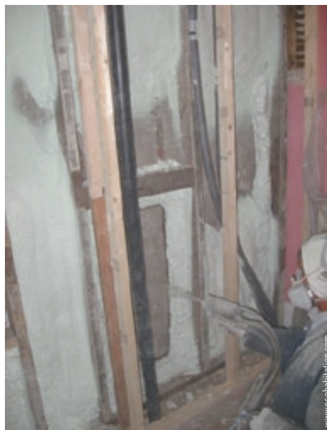
Écohabitation maison LEED : Isolation giclée en plastique recyclé et en huile de soja.
