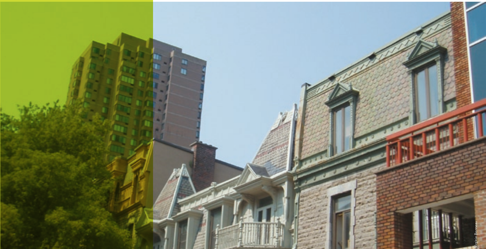
📍 Vue de la rue Hutchison.
