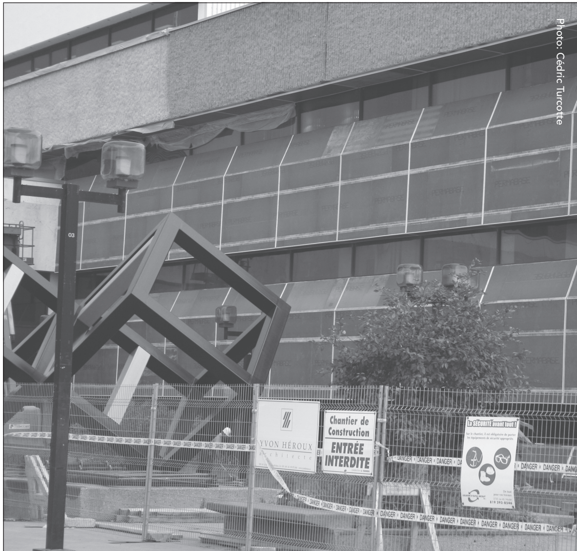
Voici l'un des nombreux chantiers de construction sur le campus de l'Université.
