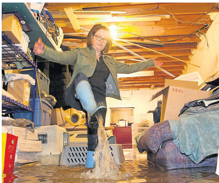
Marie-Josée Nobert, de la boutique Entre chiens et chats, doit gérer un important dégât d'eau pendant que le propriétaire de son immeuble et la Ville de Shawinigan se renvoient la balle. — PHOTO: SYLVAIN MAYER
