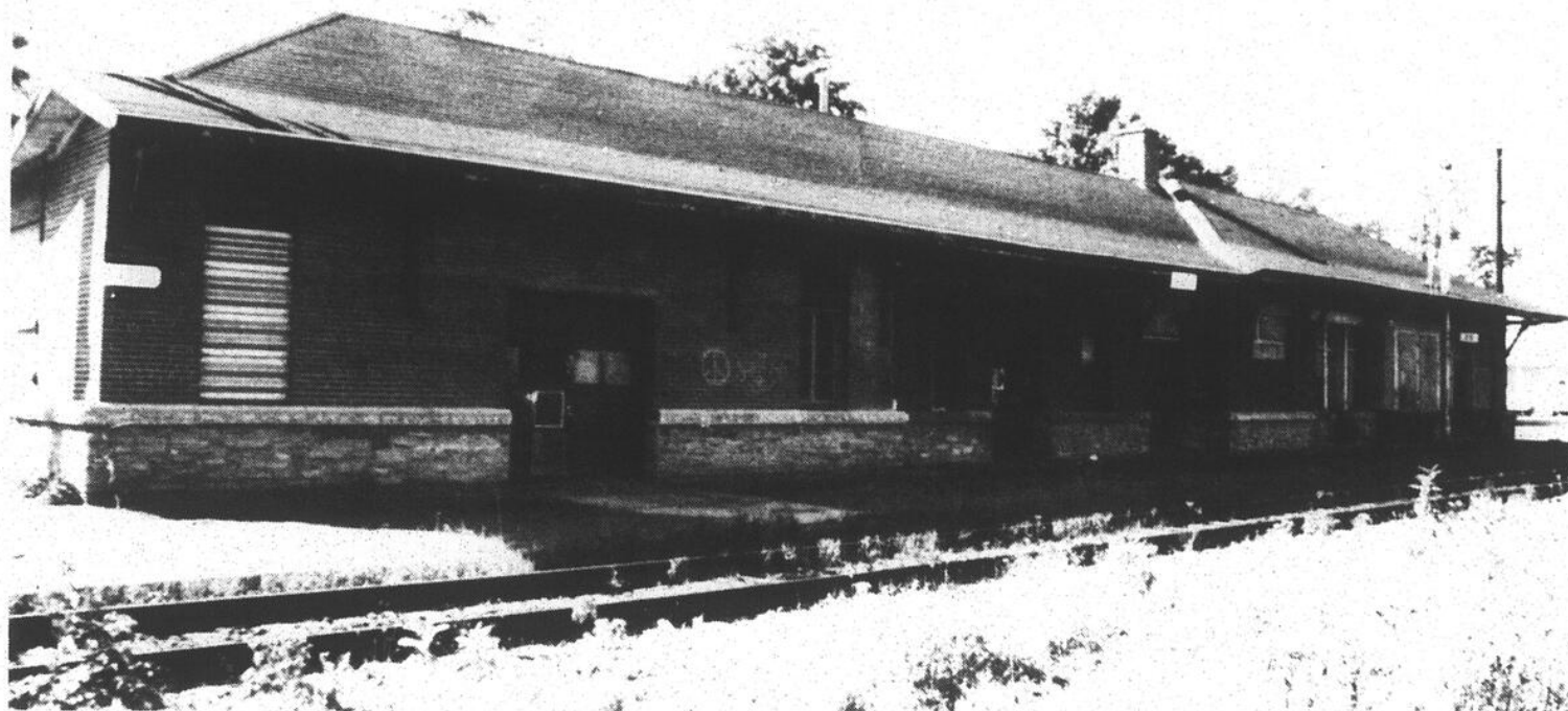
La Commission des lieux et monuments historiques du Canada fait plusieurs suggestions pour la rénovation de la gare du Canadien Pacifique, dont la construction remonte à 1887.
