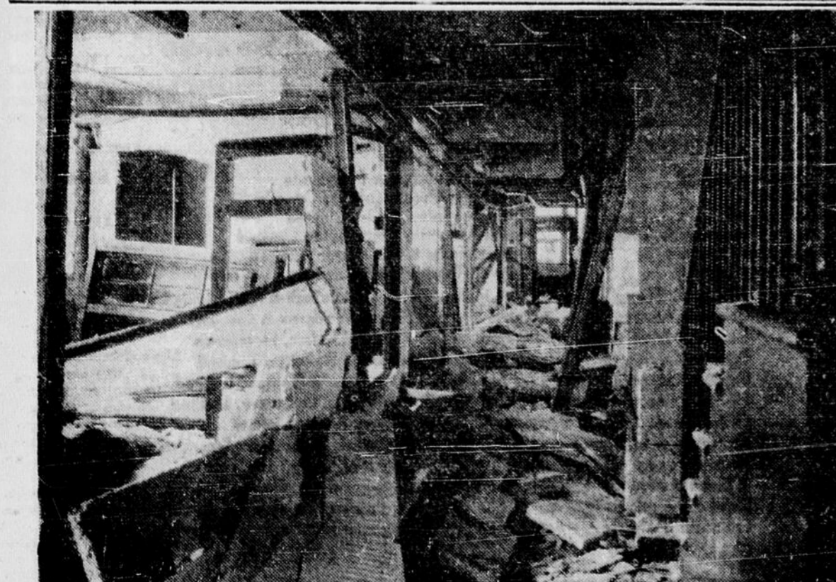
Les quartiers-généraux de la Y.M.C.A. à Londres, ont subi de lourds dégâts. Nous nous trouvons ici dans le corridor d'un dortoir. Les bombes allemandes ne semblent pas l'avoir ménagé.
