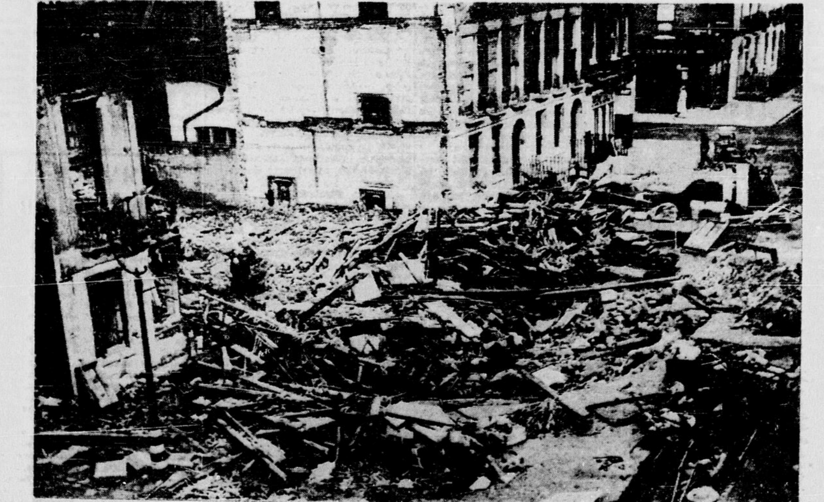
Cette photo donne une idée du travail décerné à un corps spécial de l'armée britannique. Les "pionniers" ont la charge de déblayer les rues de la capitale après que les bombes ennemies y ont causé des dégâts comme ceux que l'on peut voir ci-dessus. Aussitôt que le nettoyage est fait, on se remet à construire.
