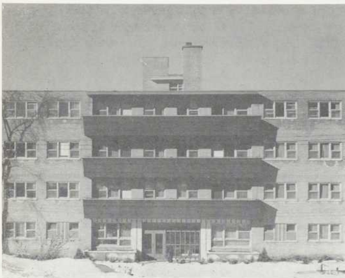
Détail de façade du même immeuble.
