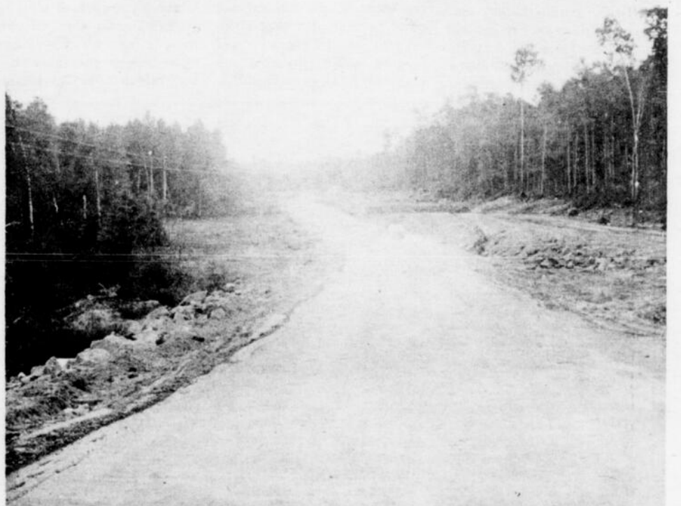
QUELQUES RÉPARATIONS à la route Chibougamau n'ont pas suffi à calmer la colère des Chibougamais qui ne veulent plus de promesses, mais "de l'asphalte".
