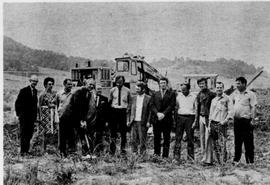
Cette semaine, à Port-Alfred, sur la rue Edmond-Savard ont débuté les travaux de construction d'un édifice devant comporter 14 logements à loyer modique, financé par la Société d'Habitation du Québec. Le contrat a été accordé aux entrepreneurs Gagnon & Lapointe de Jonquière. Cette photo nous fait voir le début officiel des travaux alors qu'on procède à la première pelletée de terre. Ajoutons que dans quelques jours, on mettra en chantier, toujours à Port-Alfred sur la rue du Parc, 22 autres logements à loyer modique. Ces deux complexes résidentiels coûteront $504,000.
