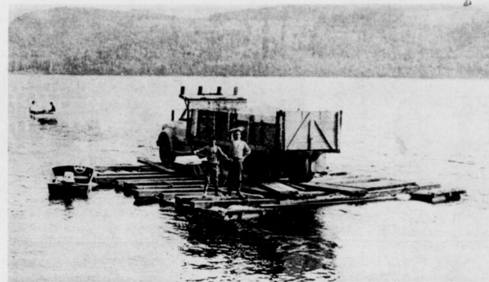
UN TRAVERSIER IMPROVISÉ — C'est là le moyen trouvé par un contracteur en transport de l'Anse Saint-Jean, M. Gilbert Lavoie pour que ses camions traversent à sec le lac Kénogami. Vingt camions ont refusé l'aventure avant M. Lavoie. Ce dernier fait huit voyages par jour quand tout va bien. 132 barils supportent le radeau sur lequel s'embarque un poids de 50,000 livres! Ce moyen de transport peu commun sert à transporter du sable et du ciment à partir de la partie du lac la plus près de Saint-Cyriaque jusqu'aux montagnes situées à l'autre extrémité du cours d'eau, pour le compte de l'Hydro-Québec qui construit des pylônes à cet endroit. Les camions doivent franchir une étendue d'eau d'environ un mille de long. (Photo Gilles Blackburn)
