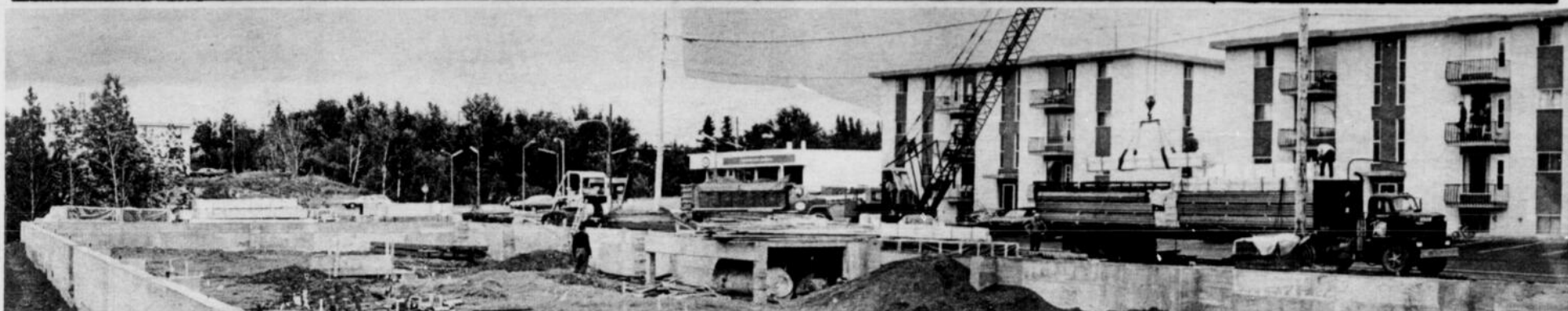
Voici où en est rendue la construction du nouvel édifice de Bell Téléphone qui s'élèvera à l'angle des rues Bégin et Dubé à Chicoutimi. Comme on le sait, cet édifice servira à centraliser divers services de la Compagnie.
