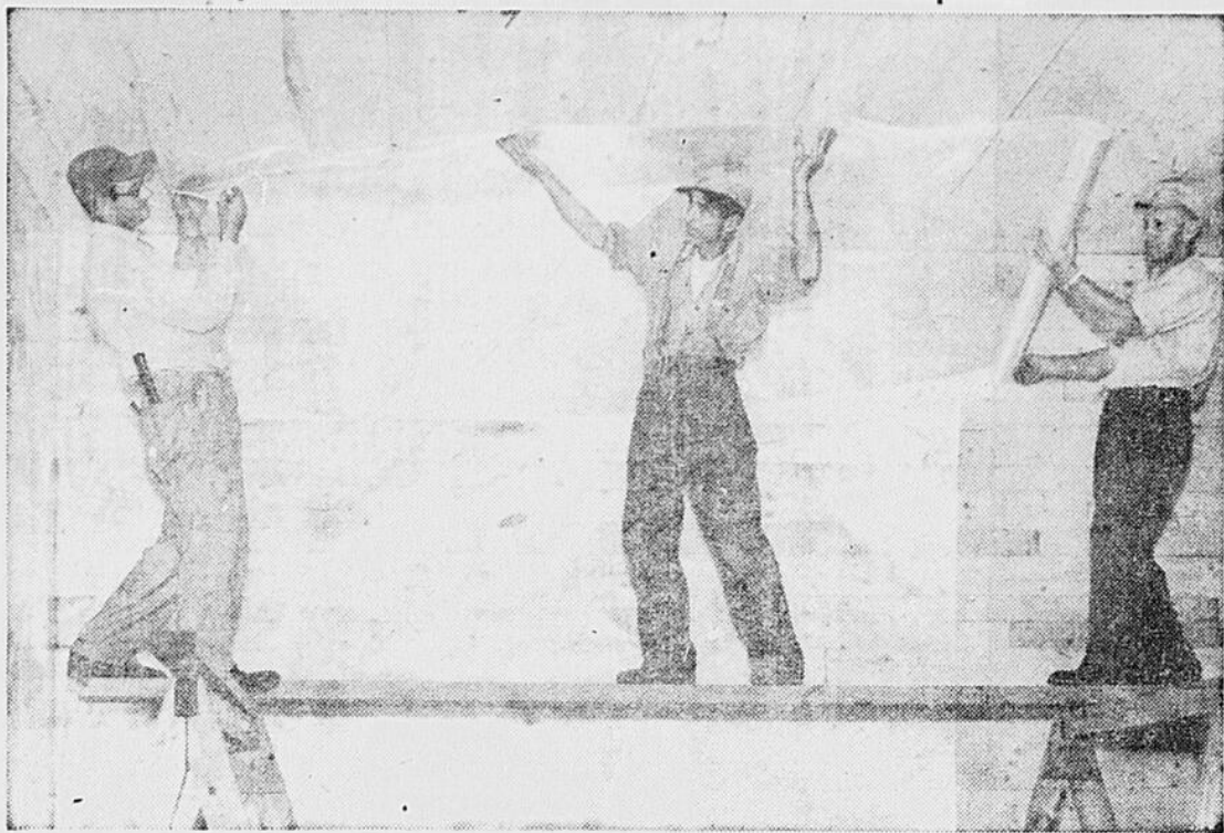
Cette chambre d'entreposage de la vallée d'Annapolis, la première du genre, est doublée d'une pellicule de plastique qui la rend étanche aux gaz. Ci-dessus, des ouvriers mettent en place de la pellicule polyester "Mylar" dans ce nouveau bâtiment, propriété de Welch-Lo Farms, à Wolfville, N.E.
