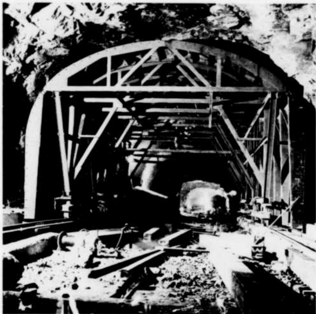
Figure 2 — Unité de coffrage métallique.
