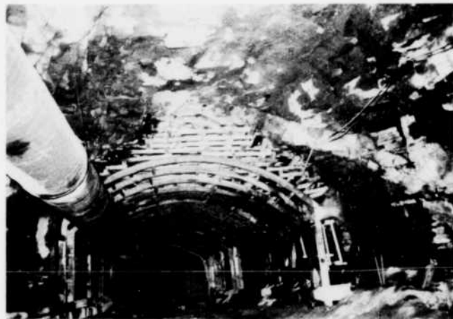
Figure 5 — Intrusif un peu altéré remontant de droite à gauche pour passer au-dessus de la voûte dans un massif très fracturé au voisinage de la faille de West-mount.
