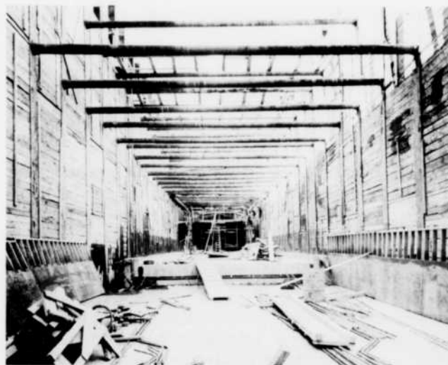
Figure 3 — Structure construite en tranchée dans la terre.
