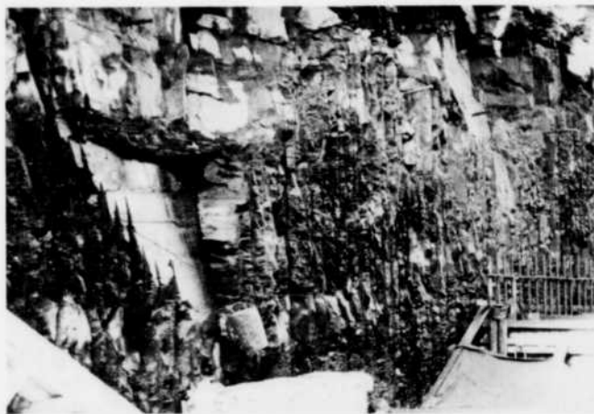
Figure 3 — Hors-profil dans la paroi au nord de la station Jolicœur. Le roc est formé par les shales d'Utica recoupés juste en bas du hors-profil par un filon-couche épais de 30 cm.
