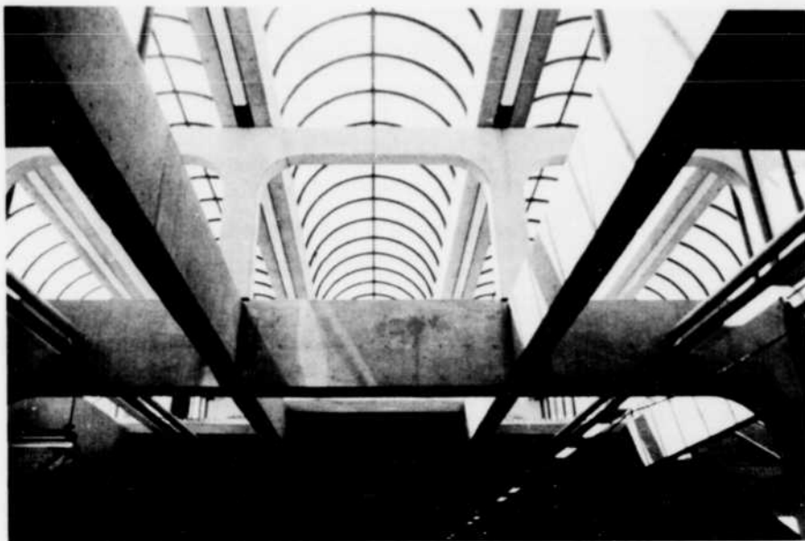
Figure 2 — Station Angrignon (par J.L. Beaulieu, architecte au B.T.M.)
