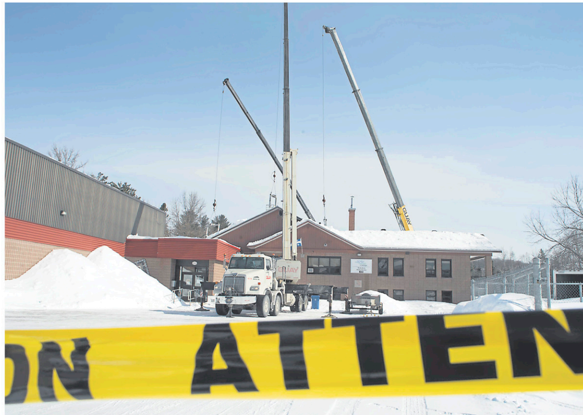
Des travaux sont entrepris sur la toiture de l'école Petite-Rivière du secteur Saint-Gérard-des-Laurentides.
