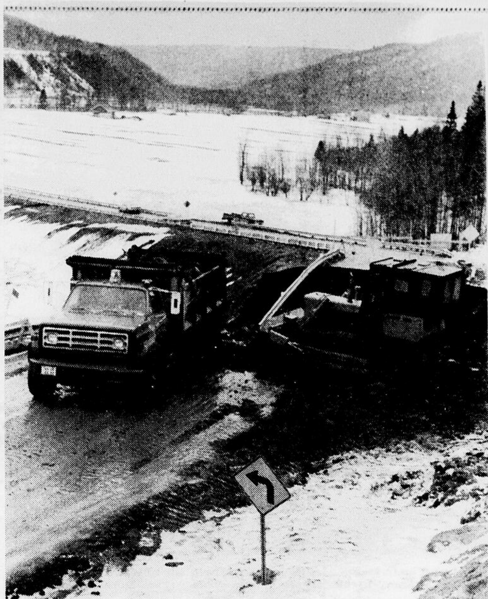
Des camions transportent de la pierre pour combler le vide laissé par la partie de route emportée. Le tuyau qui canalisait les eaux vers la rivière au bas de la pente a été lui aussi complètement emporté. [Photos Gilles Gagné]
