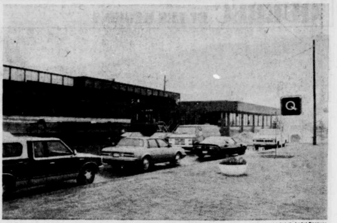
La nouvelle partie du Centre administratif et de services d'Hydro-Québec à Lévis, à gauche. Le bâtiment, dont la superficie de plancher sera multipliée par quatre, doit être terminé au cours de l'été.
