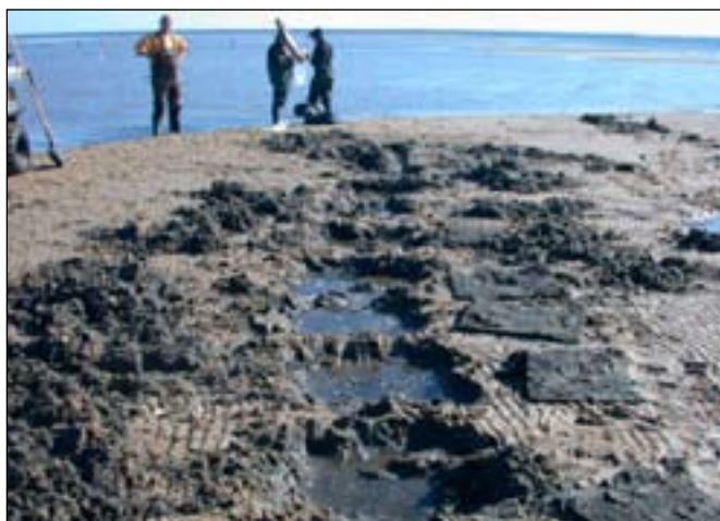
Photos 2 et 3. Récupération en septembre 2006 des tapis des niveaux 8, 9 et 10 ensablés profondément sous un banc de sable.
