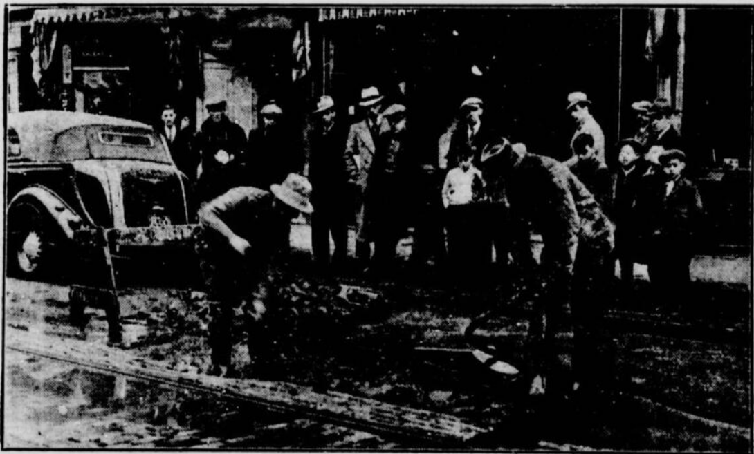
Ce matin, vers 8 heures, rue Ste-Catherine, angle de la rue Ste-Elizabeth, un tuyau conducteur se brisait. Un jet d'eau jaillissait aussitôt. La ville dépêcha immédiatement une équipe de secours d'urgence, pour réparer les dommages. Ci-haut, une photo des hommes à l'ouvrage. (Photo la "Patrie").
