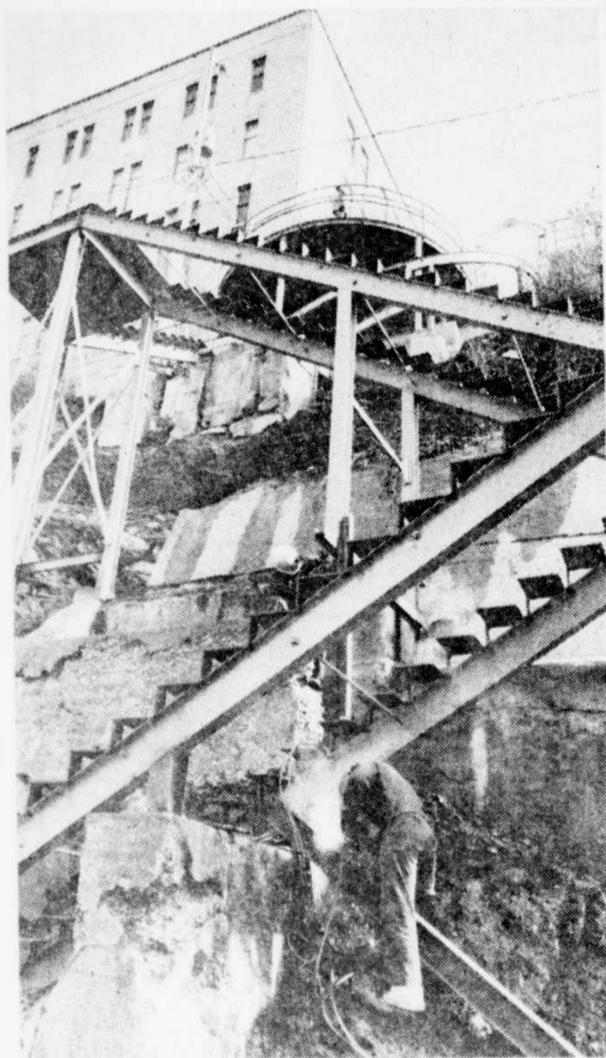
On refait l'escalier, face au Soleil.
