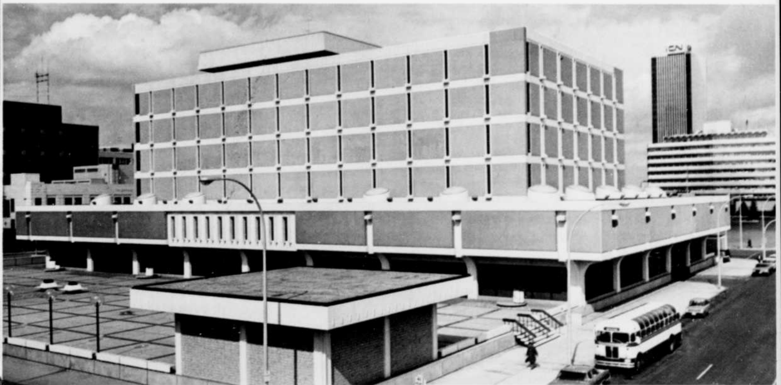
7. La Librairie du Centenaire à Edmonton met en valeur la souplesse du béton préfabriqué. L'édifice du Canadien National est à l'arrière-plan.
