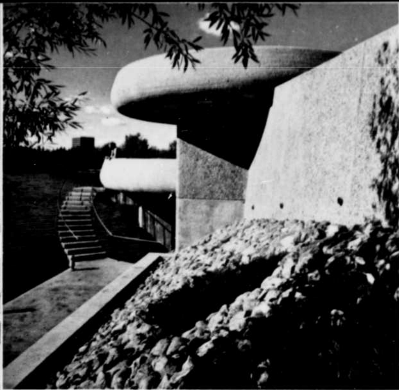
5. L'Usine de Pompage du Centre Wascana, Régina, Sask., réalisation originale.
